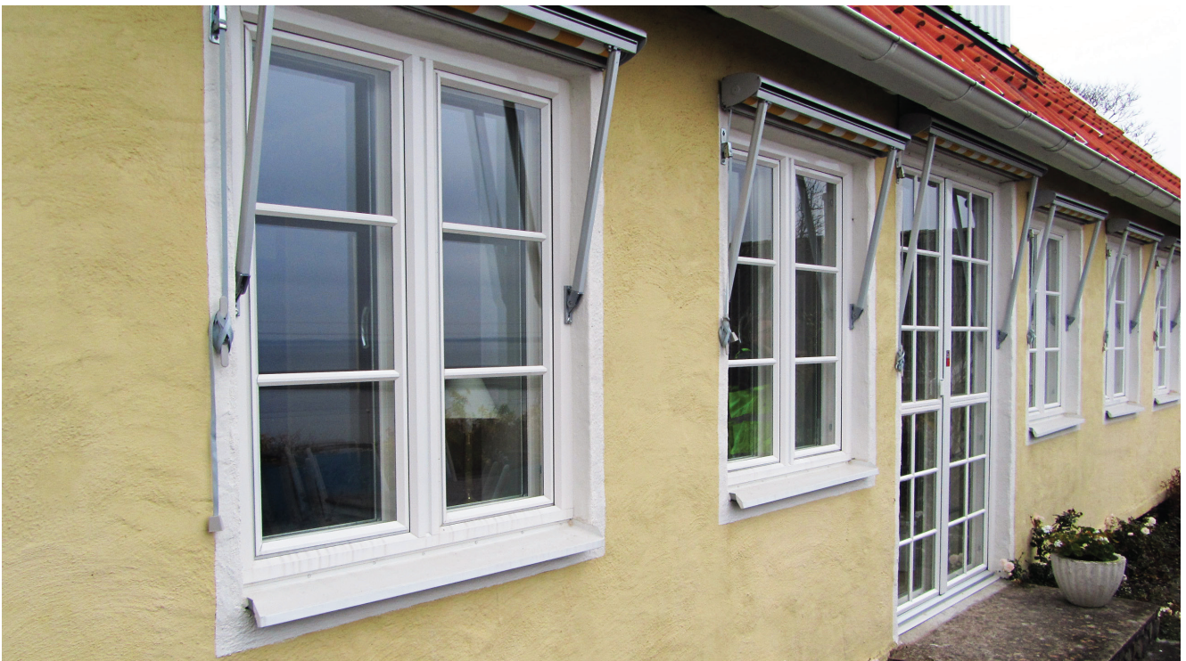
Fönster och friskluftsventiler är i många fall den ljudmässigt svagaste delen på en husfasad. En av Trafikverkets vanligaste åtgärder för att minska bullernivåer inomhus är att göra ett fönsterbyte.
