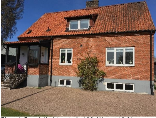
Figur 6. Fasad direkt mot väg 109, Kågeröd 3:21.
