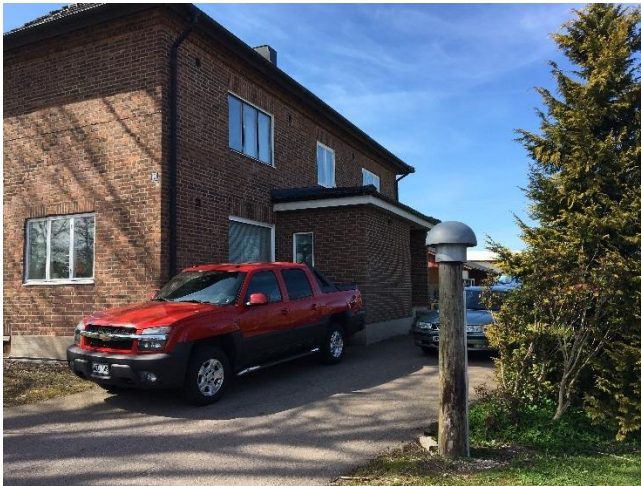
Figur 7. Fasad direkt mot väg 109, Kågeröd 3:20.
