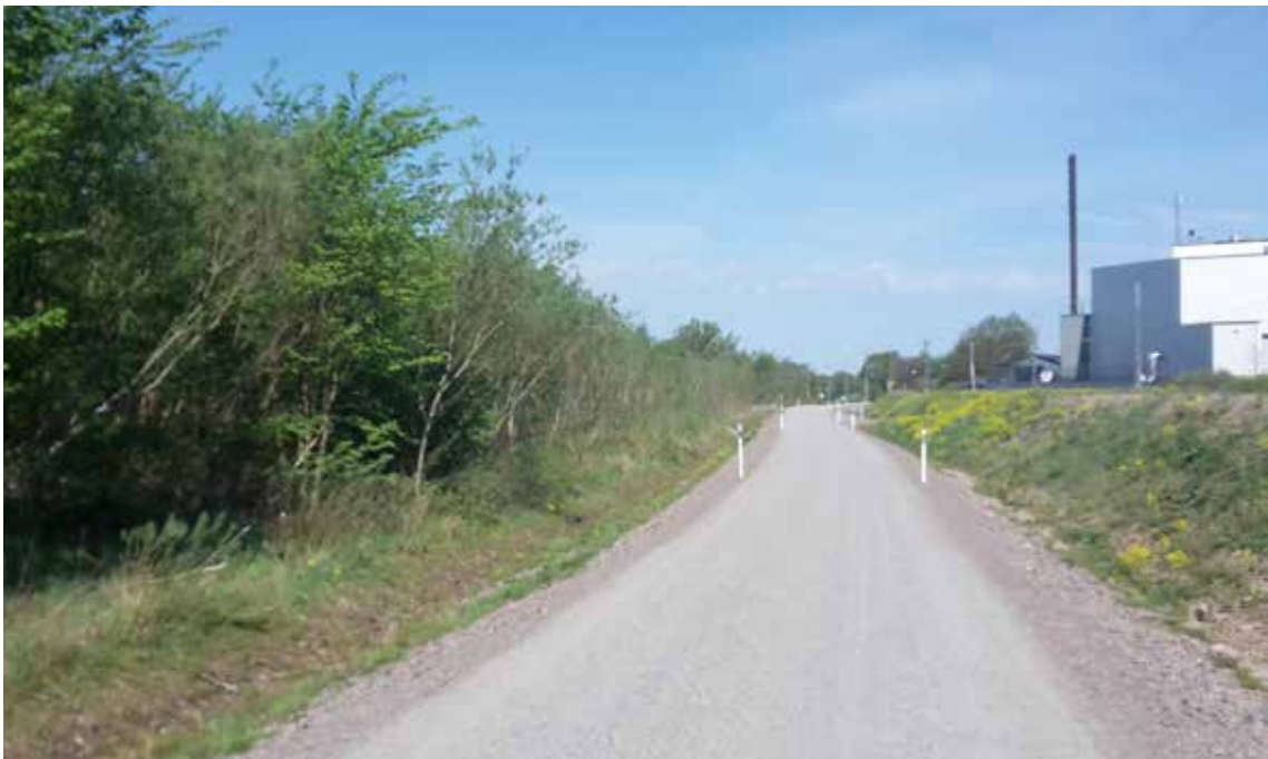
Foto - Industribyggnad och järnvägsbank.
