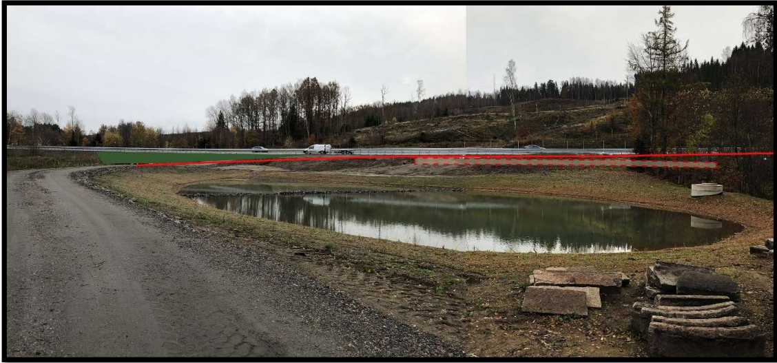
Figur 35. Gång- och cykelvägen ansluter till Kärrbogärdevägen vid dagvattendammen, se dragning i röd linje. Stödmur för gång- och cykelvägen kan antingen avslutas innanför trädridan eller vid dagvattentrumman, stödmuren illustreras i röd streckad ruta. Om stödmuren utförs som en gabionmur kan den bidra till bra landskapsanpassning som ger anläggningen en gestaltningsmässig koppling till stenmurar vid Kärrbogärdevägen. Foto: Mika Määttä, AFRY
