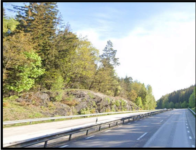
Figur 33. Breddning av vägkorridoren för E20 för gång- och cykelvägen kommer innebära att bergskärningar blir ett mer märkbart inslag i landskapet närmast E20. Jämfört med motorvägens bergskärningar kommer tillskottet dock att vara marginellt. Bilden visar platsen för utökad bergskärning sett mot Ingared. Foto: Google
