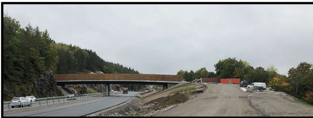
Figur 14. Det nyanlagda Högelidsmotet. Gång och cykelvägen är planerad att lokaliseras norr om rampen upp mot det norra brofästet. Sett mot Tollered. Foto: Mika Määttä, AFRY
