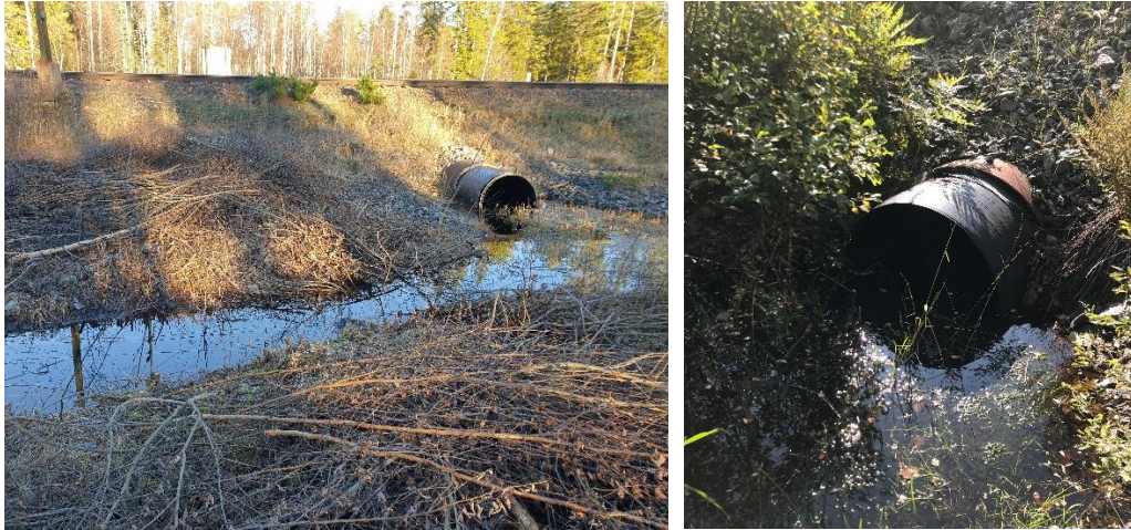
Figur 12. Trumma under järnvägen vid km 168+117. T.v. inloppet och t.h. utloppet.
