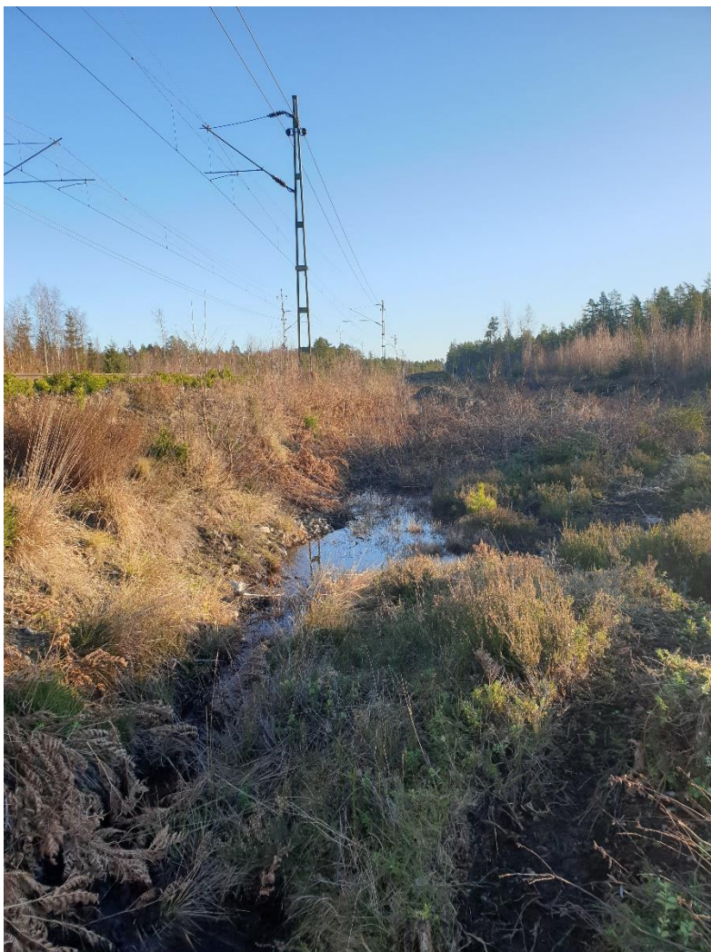
Figur 7. Exempel på stående vatten nära järnvägsbankens släntfot i planområdets västra del. Bilden tagen på södra sidan om spåret med vy mot öster.
