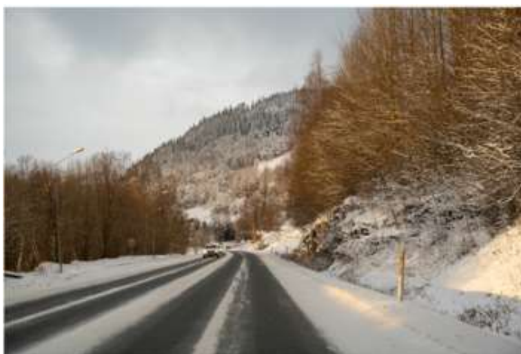
Figur 4.6.5.1. Bilden visar bergskärning 3483. Fotot är taget mot nordväst.
