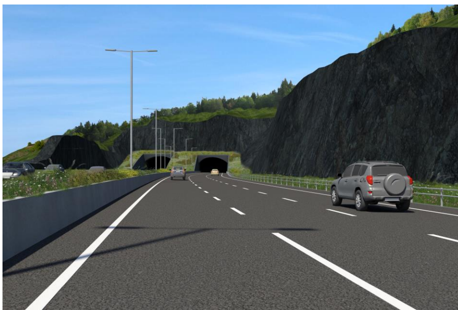
Figur 10 Förskärning vid Masmotunnelns södra mynning
