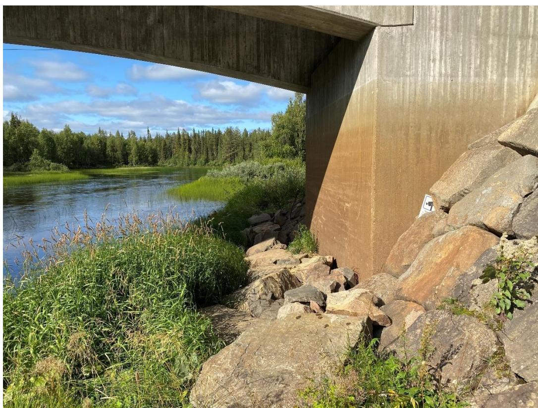
Figur 5. Befintlig bro över Råneälven med utterstig på den östra sidan av älven.
