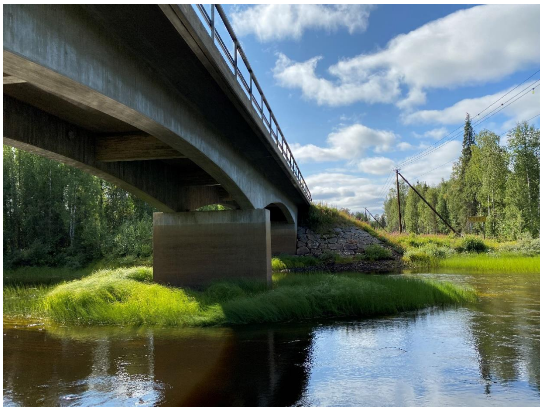
Figur 4. Befintlig bro sett snett underifrån från den östra sidan av älven.
