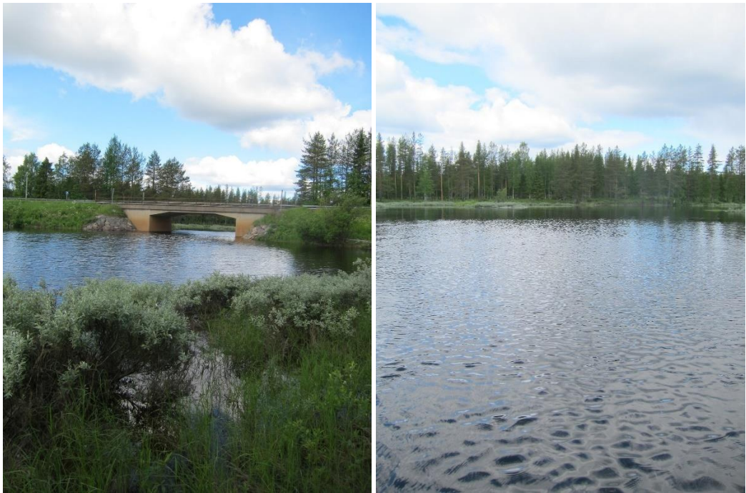
Figur 6 och 7. Vy mot väster, vägbron över E 10 i bakgrunden respektive uppströms vägbron.
