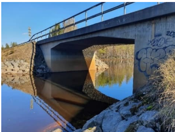
Figur 3. Befintlig bro över Kälvån
