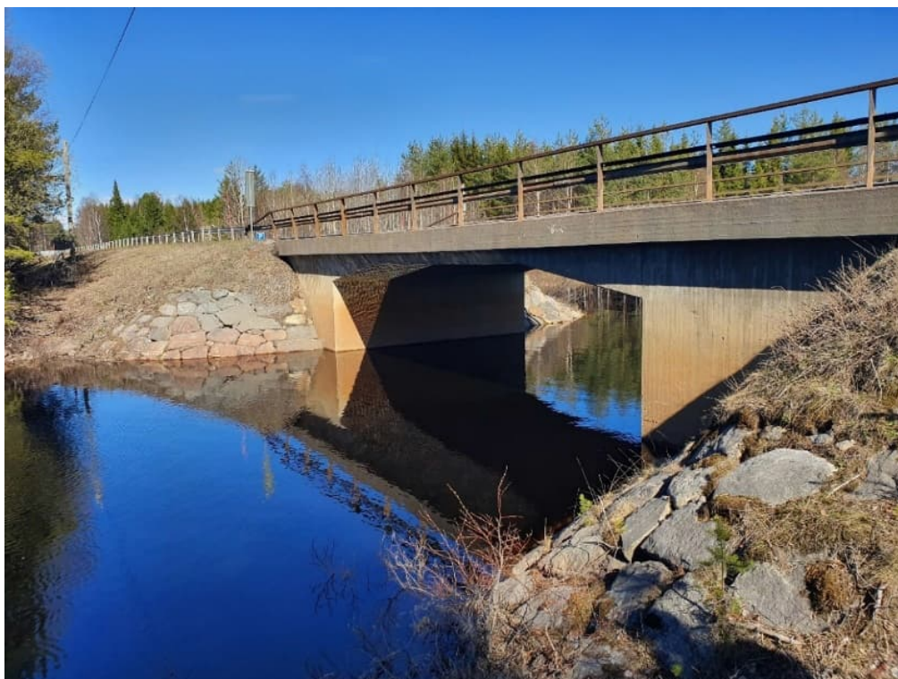
Figur 8. Befintlig bro över Grundträskån.
