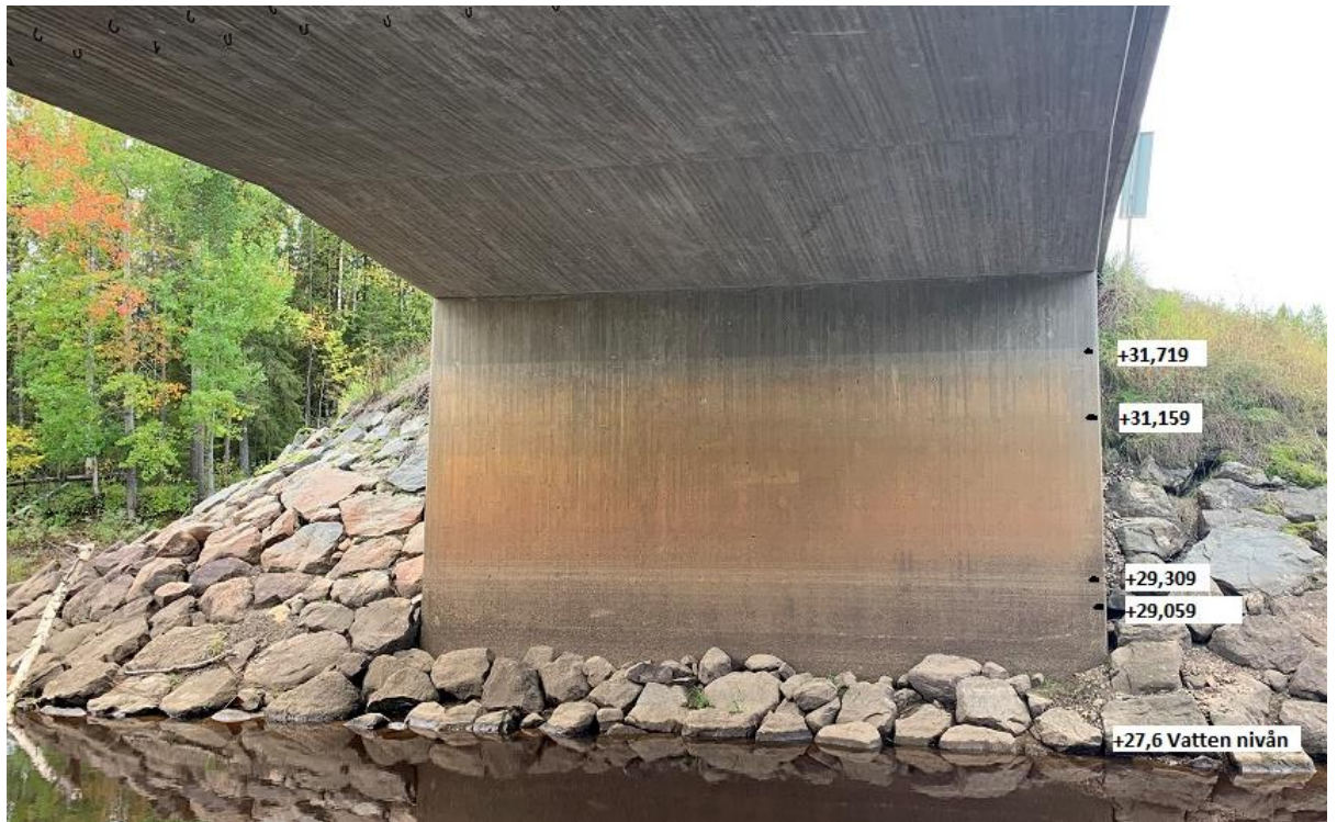
Figur 3: Inmätta vattenmärken på befintlig bro över Kälvån, inmätning gjord 2019-09-17.
