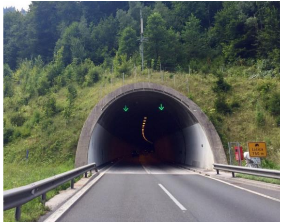
Bild 5.11 Bilden visar platsgjutna enkla portaler. Järnvägen går i skärning innan tunneln vilket ger ett litet annat uttryck än denna vägtunnel.
