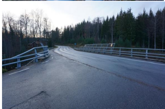
Bild 5.21 Bilderna visar den enda planskilda korsningen utmed sträckan. När denna byggdes tog Trafikverket höjd för utbyggnaden av dubbelspåret.
