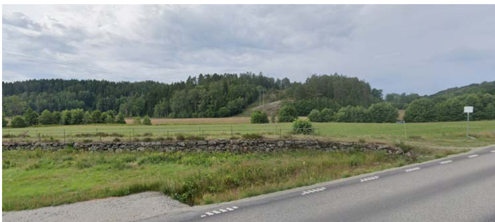
Figur 4.5.4:4 Den äldre vägbanken vid Rotviksbro.
