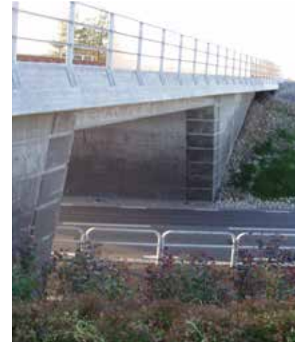
Figur 4.5 Relief med horisontella lister. En högre detaljering markerar öppningen.
