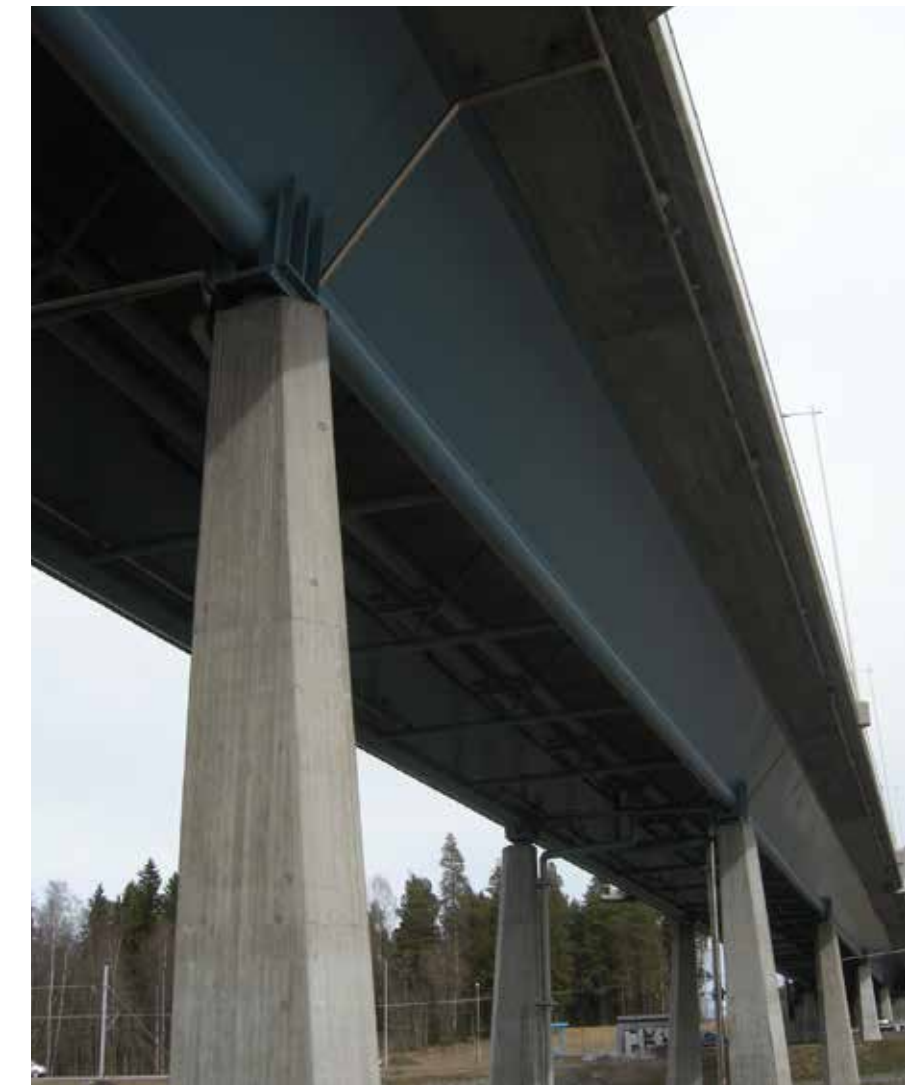
Figur 4.10 Ett bra exempel på färgsättning av en större bro över Umeälven där färgen på ställådan harmonierar både med älven och himlen.
