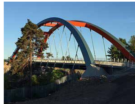
Figur 5.32 Exempel på bågbro över järnväg i Västberga, Stockholm
