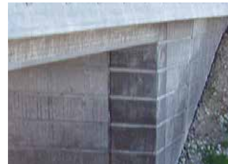
Figur 5.17 Exempel på bro med enkel relief i betongen som gör att betongytan får en mera bearbetad detaljering och karaktär.
