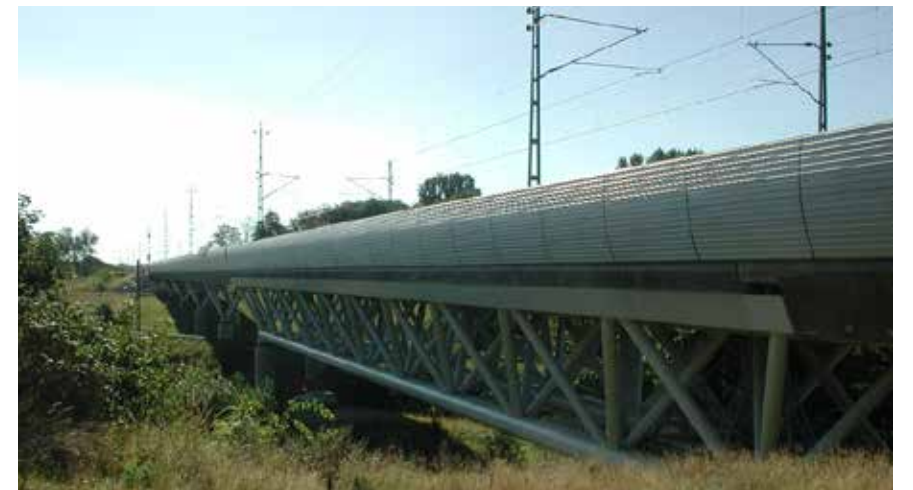
Figur 4.15 Exempel på bullerskyddsplank i stål med jämn överkant.
