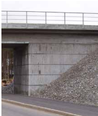
Figur 4.6 Exempel på betongyta med enkel relief.
