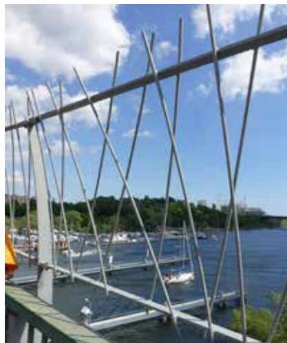
Figur 4.24 Exempel på ett suicidskydd som har god funktion, form och genomsikt.
