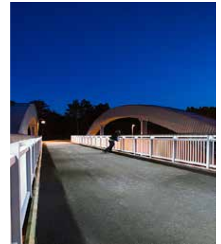
Figur 4.21 Exempel på belysning/ljussättning där ljuskällorna är integrerad i räcket.
