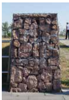
Figur 5.14 Exempel på mur uppbyggd av gabioner
