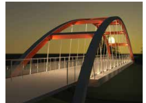
Figur 5.33 Exempel på ljussättning av bron som är integrerad i brokonstruktionen.
