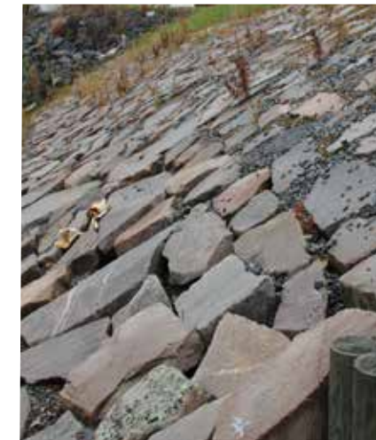
Figur 4.9 Exempel på glacis. Exponerade brokoner kan läggas med välordnad större sprängsten.
