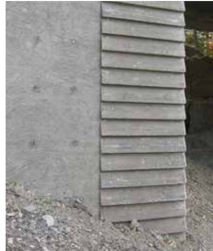
Figur 4.4 Exempel där landfästets hörn getts en högre detaljering med form av fjällpanel.
