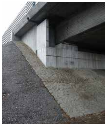
Figur 4.8 Exempel på välordnad fältsten under bro.
