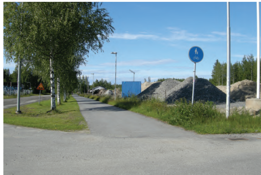
Figur 3.1-3 Den kommunala gång- och cykelvägen genom industrikravaren i Ersboda. Foto: Tyréns AB.
