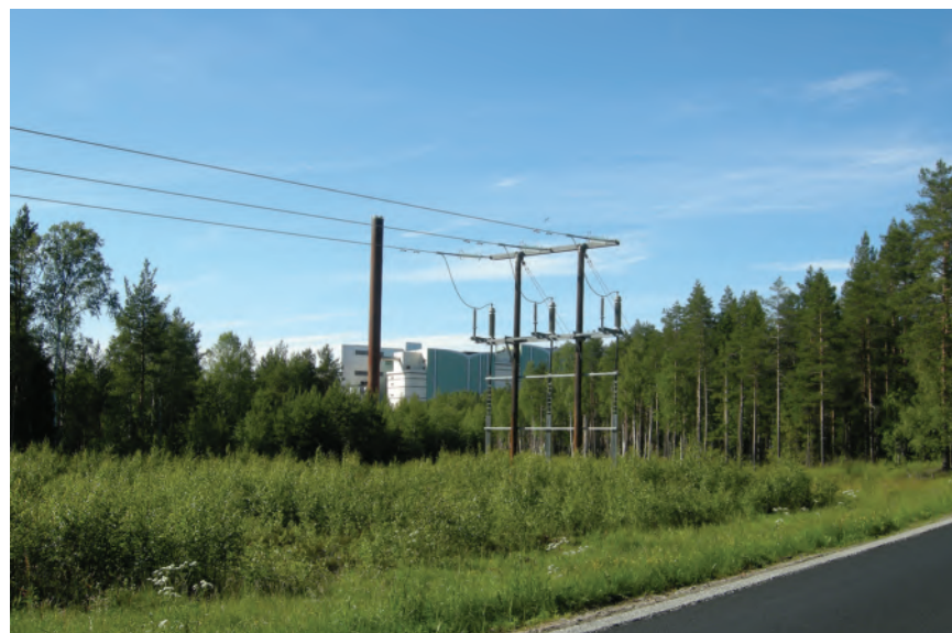
Figur 3.3-1 Dåva kraftvärmeverk. Foto: Tyréns AB.
