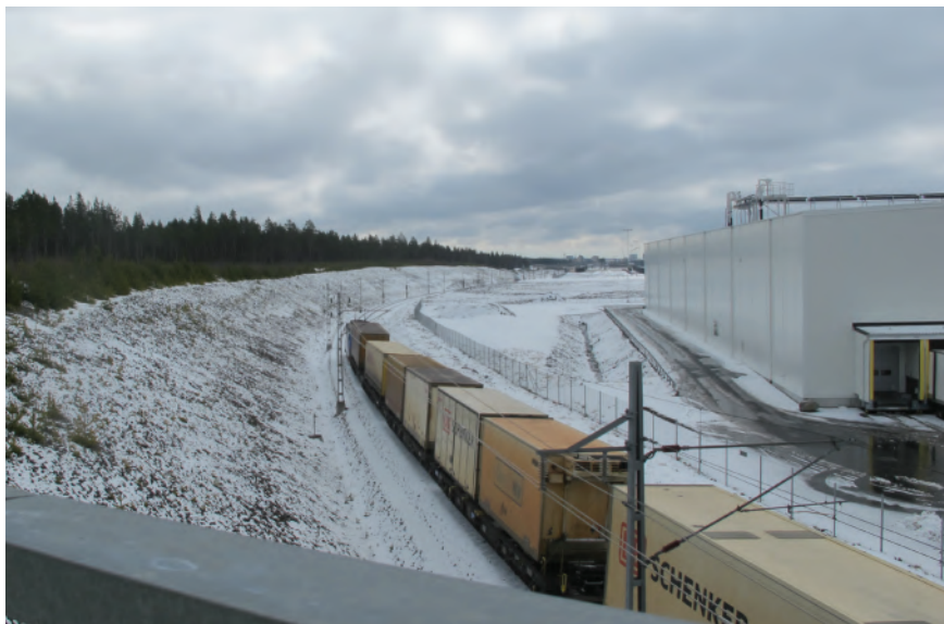
Figur 3.1-4 Umeå godsbangård. Foto: Tyréns AB.
