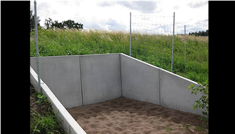
Figur 66 exempel på utformning av viltuthopp
