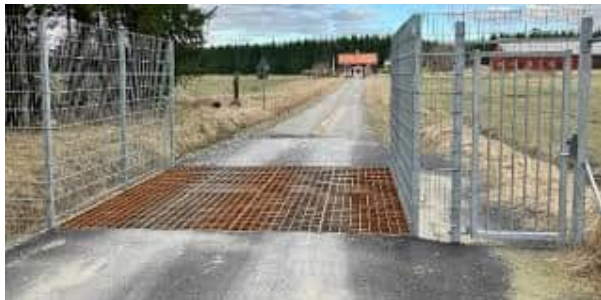
Figur 64 exempel på utformning färist
