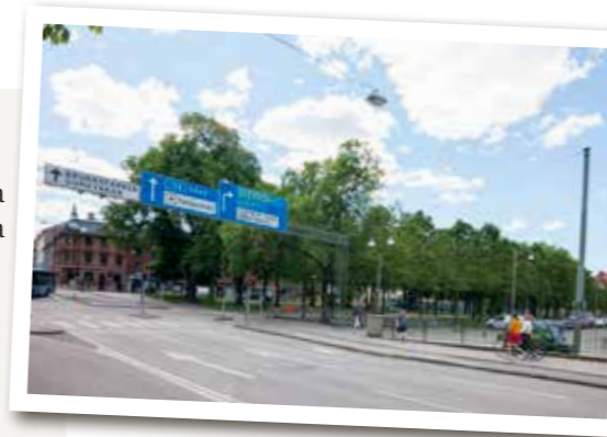
Vi monterar ned Rosenlundsbron i ett tidigt skede av byggnationen och ersätter den med en tillfällig gång- och cykelbro öster om den befintliga bron. FOTO: RAPHAEL PALOMO
