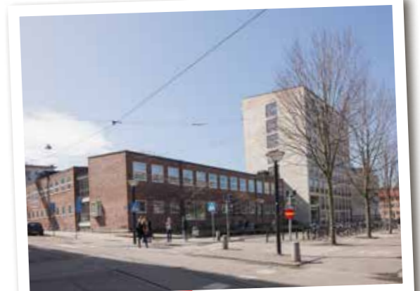
Akademiska Hus ska uppföra en ny byggnad för Göteborgs Universitet vid hörnet Vasagatan och Haga kyrkogata. Som en del av arbetet ska Västlänken förbereda stationsentrén i den nya byggnaden. FOTO: RAPHAEL PALOMO
