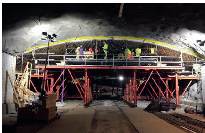
Med start den 27 december kommer Västlänkens deletapp Kvarnberget att utföra förstärkningsarbeten i Götatunnelns norra tunnelrör. Vid Otterhällan påbörjas arbetet den 4 januari. Bild Trafikverket.
