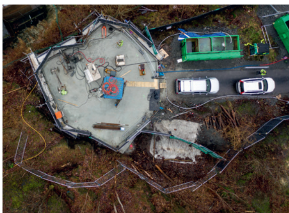
Med start i september började vi förbereda för byggnationen av det ventilationsschakt som ska byggas vid Föreningsgatan. Foto: Kasper Dudzik.
