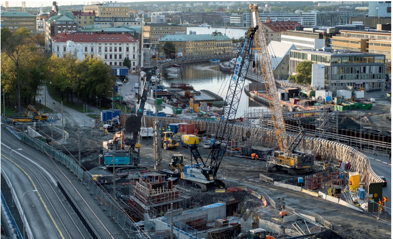
Under hösten och vintern fortsätter arbetet med station Haga i Pustervik och vi förbereder arbeten inför gjutning av nästa del av tunneltaket. Gjutningen sker efter årsskiftet, preliminärt i april 2021. Bild Trafikverket.
