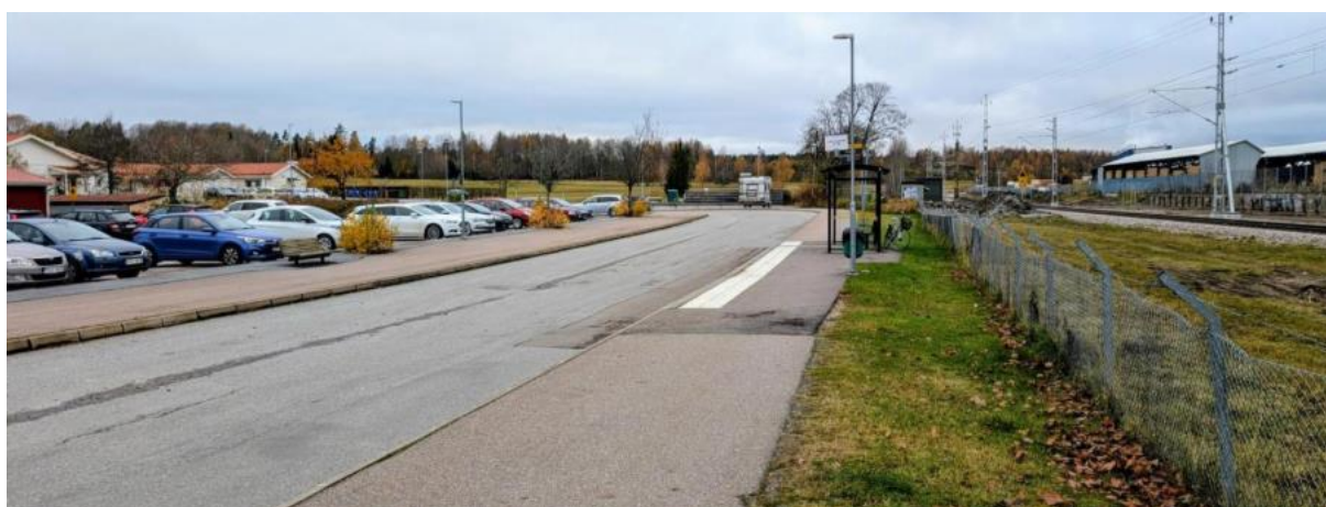
Figur 6. Hållplats med busskur vid bytespunkt. Pendelparkering syns i vänsterkant av bild.
