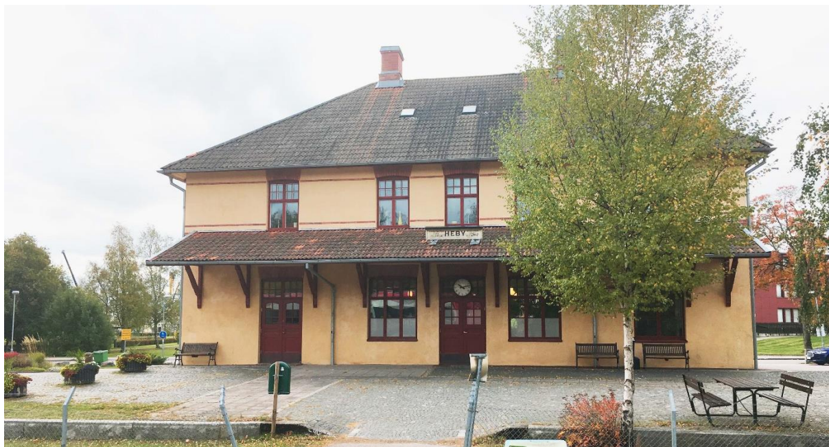
Figur 9. Stationshuset med entréplats mot spåren, belagd med smågatsten.
