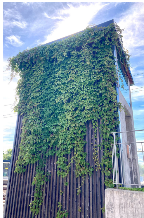
Figur 35. Hiss med vägg klädd med träribbor, bevuxen med klängande växter. Exempel från Knivsta station.
