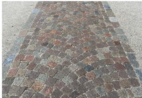
Figur 20. Smågatsten används redan idag på platsen. Smågatsten föreslås i gestaltningen som markmaterial tillsammans med stensmjöl, gräs och asfalt.
