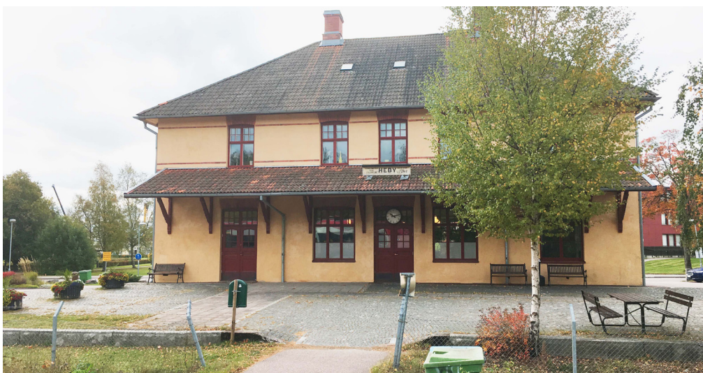
Figur 5. Stationshuset med entréplats mot spåren, belagd med smågatsten.
