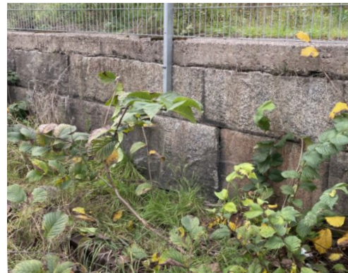
Figur 21. Granitsten som tidigare utgjort mur till plattformar, återanvänds i den nya gestaltningen.
