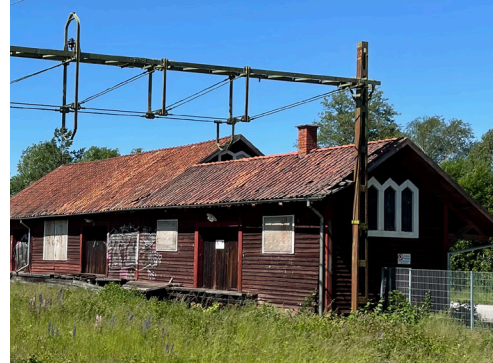
Figur 33. Befintlig bebyggelse i området med falu rödfärg.
