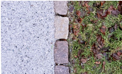
Figur 17. Friser av storgatsten föreslås skilja ytor med olika markmaterial från varandra inom stationsområdet.
