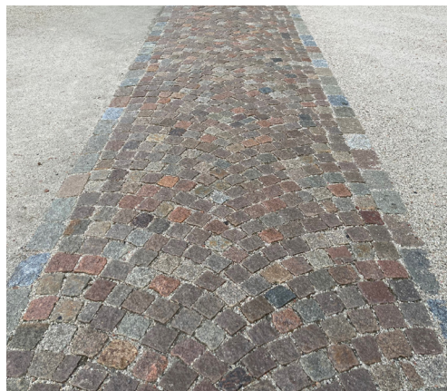
Figur 18. Smågatsten används redan idag på platsen. Smågatsten föreslås i gestaltningen som markmaterial tillsammans med stenmjöl, gräs och asfalt.
