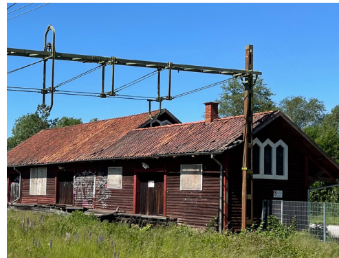
Figur 30. Befintlig bebyggelse i området med falu rödfärg.
