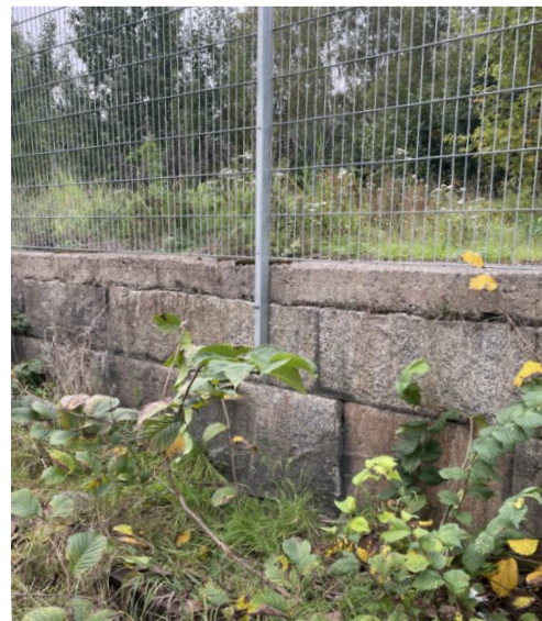
Figur 19. Granitsten som tidigare utgjort mur till plattformar, återanvänds i den nya gestaltningen.
