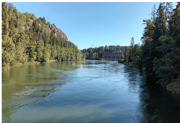
Figur 67. Vy över Göta älv, med naturreservatet Älvrumsmet på båda sidor älven. Byggnaden som syns i bilden är Olidans kraftstation.
