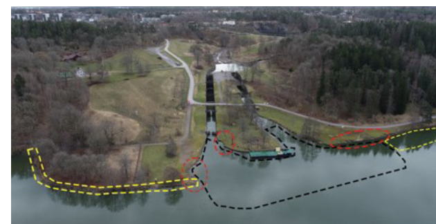
Figur 58. Vy från Göta älv över Åkers vass och 1800-tals slussarna. Gula markeringar visar erosionsåtgärder med en förstärkt strandlinje utformad likt befintlig. Svart markering är område där utredning för framtida reparation. Rött markerar är skadade partier i befintlig stenskonering.
