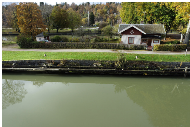
Figur 60. Murkonstruktioner vid Klaffbrons vaktbostad.
