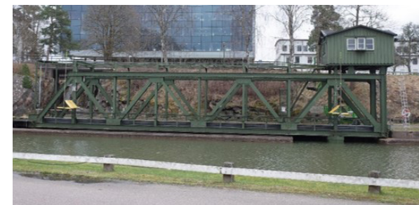
Figur 54. Nohabs svängbro (Vridbron) från 1915 är sannolikt unik i sitt slag och har ett högt kulturhistoriskt värde.
