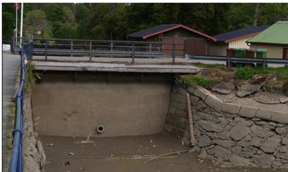
Figur 27. Befintlig avstängning i Höljan av den nedre slusstrappan i 1844 års slussled vid Höljan.
