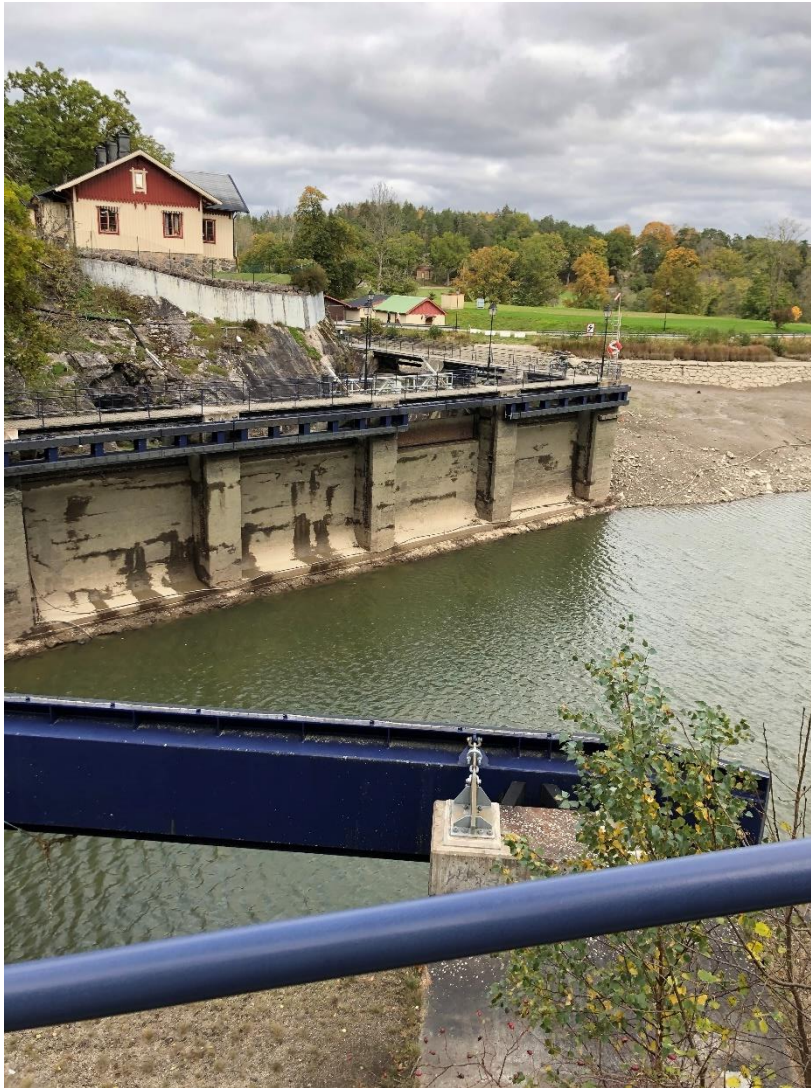
Figur 35. Kombinerat bräddavlopp och isutskov med Höljan avtappad uppströms sluss 3. Foto mot nordost.
