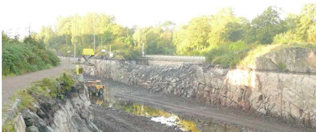
Figur 17. Norra skiljeväggen med pålagda schaktmassor på bergshyllan mot Bergkanalen.
