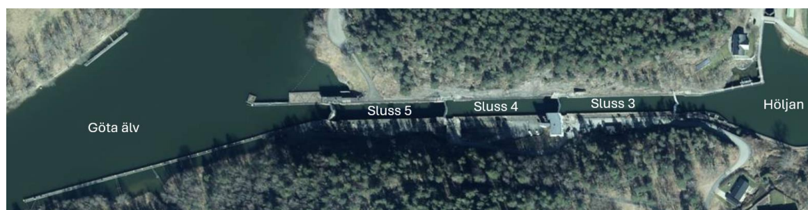
Figur 29. Översiktsbild av slussstrappan.
