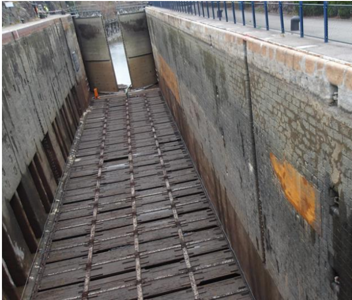
Figur 22. Övre del av dubbelbotten där vattnet kommer in i slussen (tömd sluss 2 i Trollhättan).
