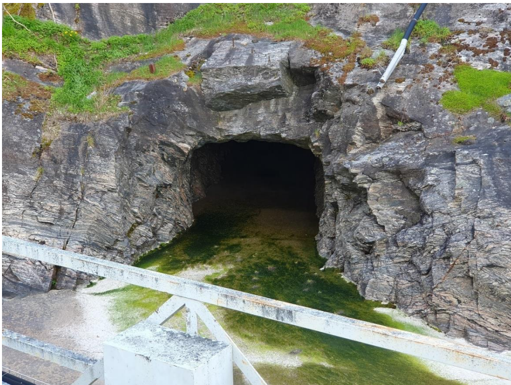
Figur 34. Intagsmynning för bergtunnel.
