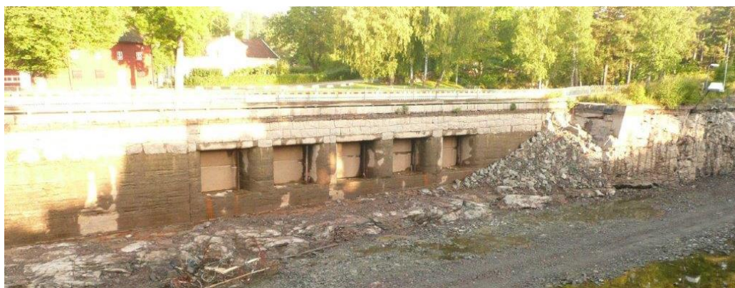
Figur 18. Södra skiljeväggen mot närliggande kraftverkskanal, foto då Bergkanalen är tömd.
