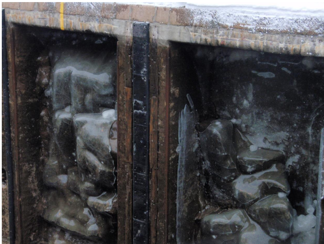
Figur 14. Is mellan betongpelare i slusstrappan, 1916 års slussled.
