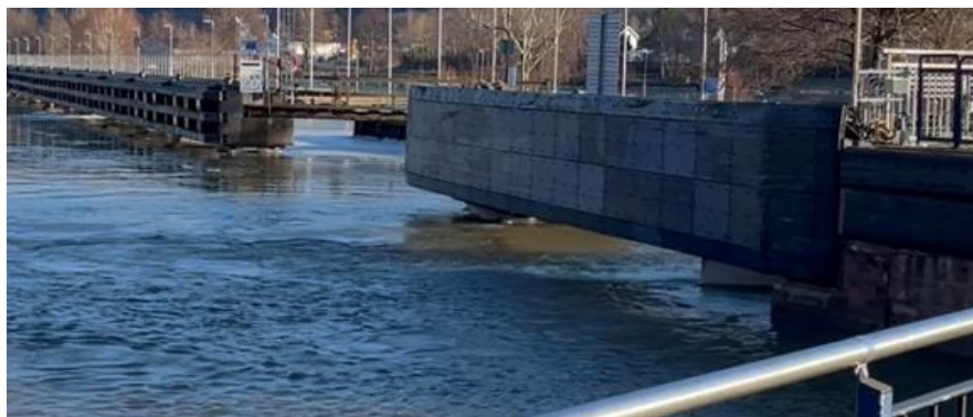
Figur 31. Strömmar bildade av strömbildare placerad under/bakom ledverk uppströms slussen i Lilla Edet.
