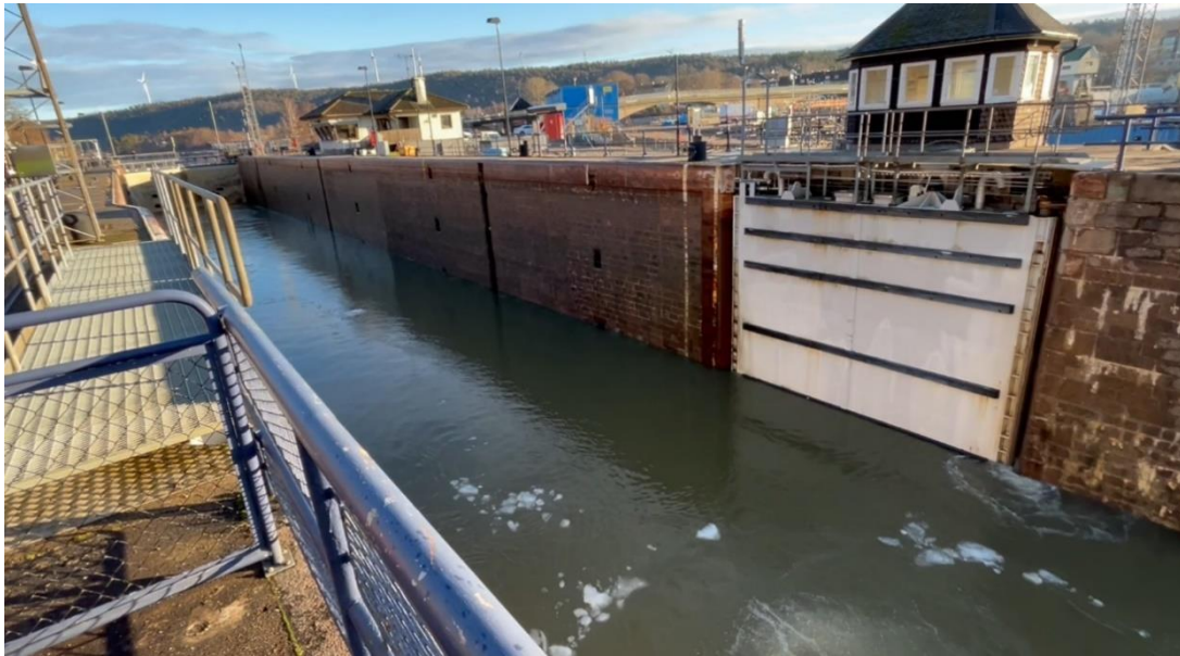
Figur 23. Port i Lilla Edet i öppet läge. Foto mot nordost.
