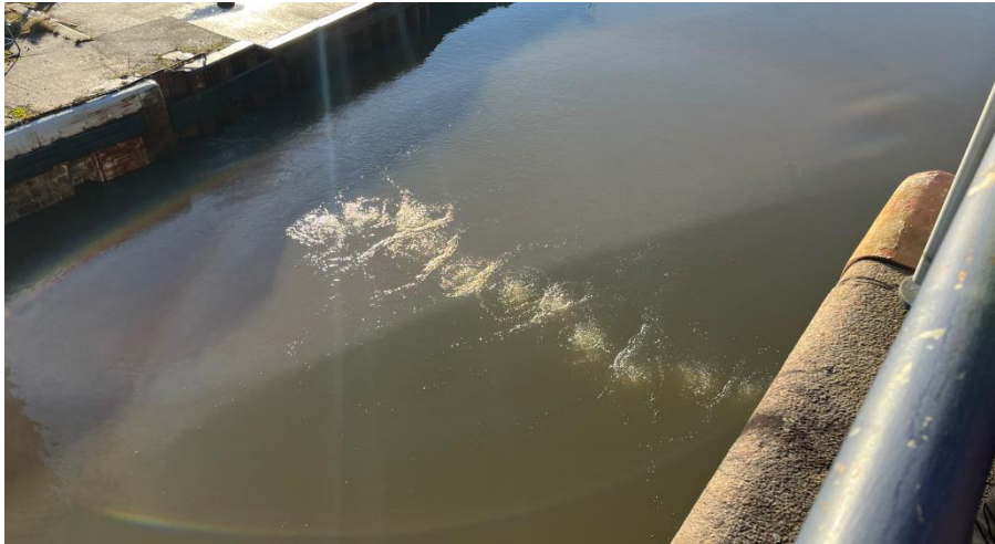
Figur 32. Bubbelridå tvärs farled nedströms slussen i Lilla Edet.
