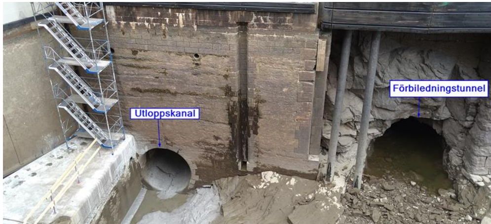
Figur 25. Utløpskanal och förbiledningstunnel i Höljan nedströms sluss 2.
