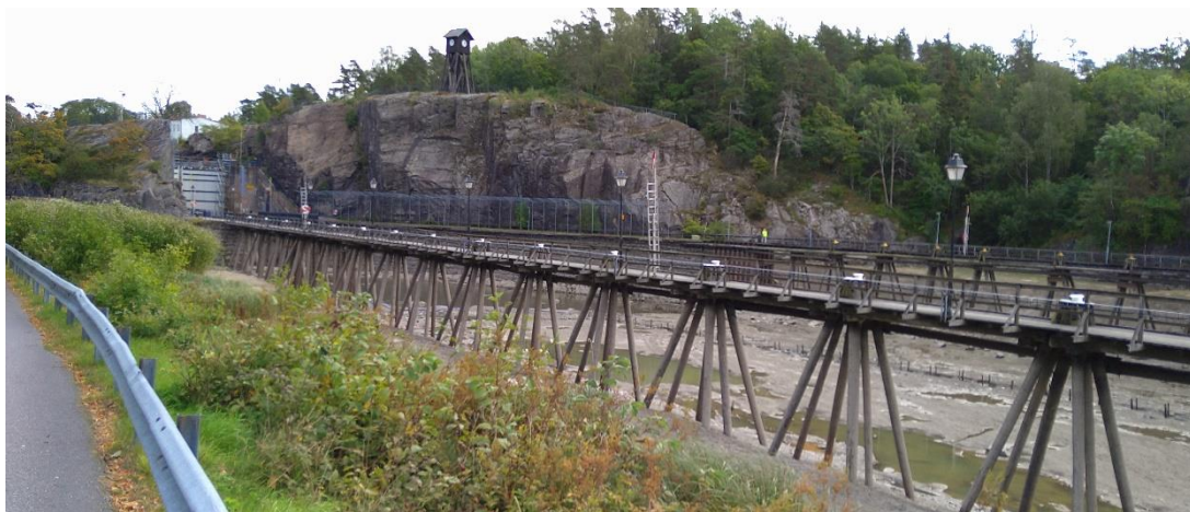
Figur 36. Dykdalber för ledverk i Höljan.
