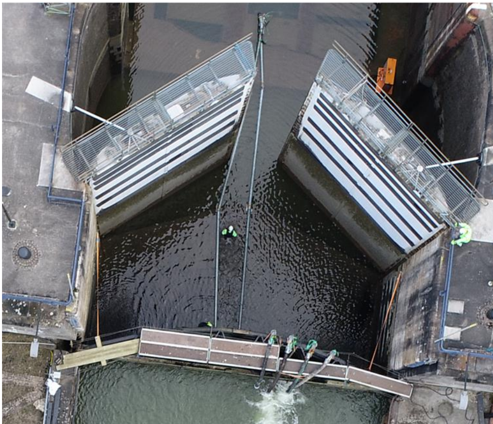
Figur 43. Befintliga stämportar Trollhättan nedströms slusshuvud, sluss 5, med monterade sättar. Urpumpning av vatten (torrläggning) pågår (WSP 2023). Figur avser illustrera porttyp.
