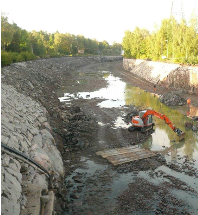
Figur 7. Bergkanalen (tömd på vatten), strax norr om korsande kraftledningar. Foto taget mot sydväst. Till vänster kanalkant som utgörs av jordslänt med erosionsskydd av huvudsakligen sprängsten och delvis glacismur. Till höger syns jordslänt skyddad med glacismur. (Foto: Sjöfartsverket)
