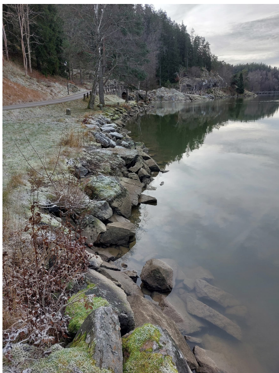
Figur 4. Befintligt erosionsskydd av sprängsten vid Åkersvass, söder om de gamla slussarna. Foto taget mot söder.
