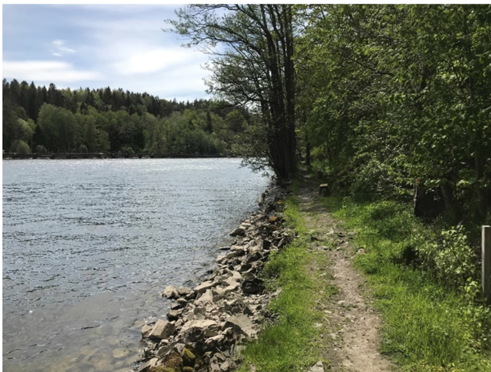
Figur 2. Befintligt erosionsskydd med gångstig vid Skälsbo. Foto taget mot söder. Bild från PM Geoteknik Fördjupad stabilitetsutredning, Skälsbo (COWI 2021).
