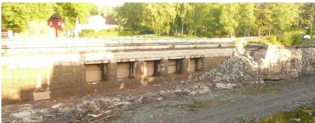
Figur 16: Den södra skiljeväggens anslutning i norr mot befintligt berg, i samband med torrläggning av Bergkanalen.
