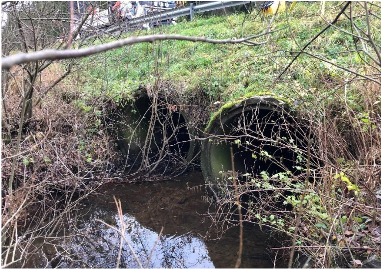
Figur 29. Inlopp trummor vid km 9/000. Väster om vägen, bild tagen mot öster.
