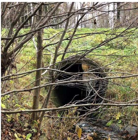
Figur 27. Inlopp trumma km 4/770, bild tagen på västra sidan av vägen med riktning mot öster
