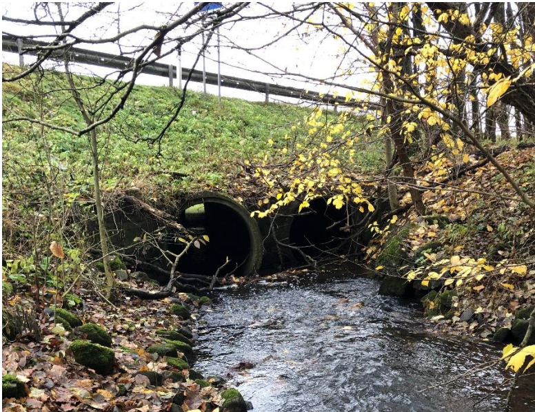
Figur 30. Inlopp trummor vid km 9/300. Öster om vägen, bild tagen mot väster.
