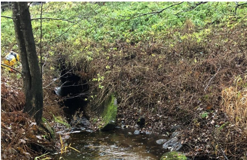
Figur 32. Sandåkrabäcken och inlopp på trumma som korsar väg 23 vid km 12/210. Öster om vägen, bild tagen mot väster.
