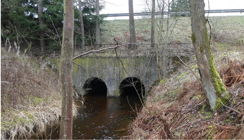
Figur 31. Mellby-Djupadalsdiket och utlopp på trummor som korsar väg 23 vid km 11/500. Väster om vägen, bild tagen mot öster.
