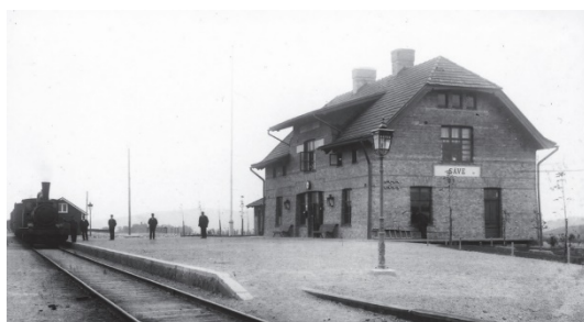
Figur 16. Stationshuset i Säve, tidigt 1900-tal, gavelfasad mot norr (Foto från Kulturmiljöunderlag Säve fd stationshus, Antiquum AB, 2019).
