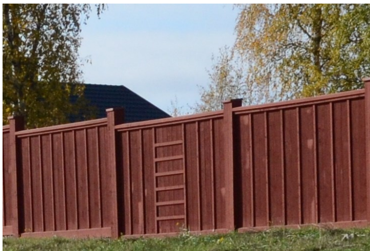
Figur 6-9. Fotot visar ett exempel på bearbetat, trappat bullerplank som kan tjäna som inspiration för utformning av bullerplanken längs sträckan.
