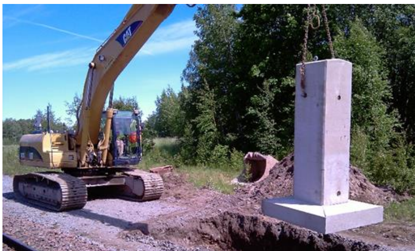
Infrastrukturministern sätter det första fundamentet på plats vid elektrifieringen av Inlandsbanan sträckan Kristinehamn-Nykroppa
