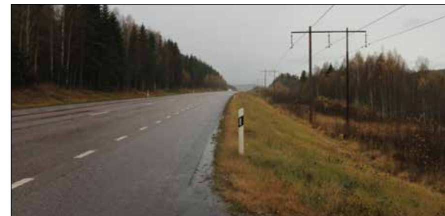
E14 söder om Vattjom med kraftledningsgatan direkt norr om vägen.
