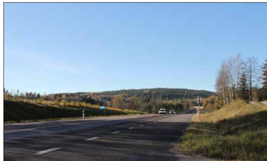
Delsträckan är i huvudsak 13 meter bred med har breda vägrenar. Vy mot korsningen vid Berg.
