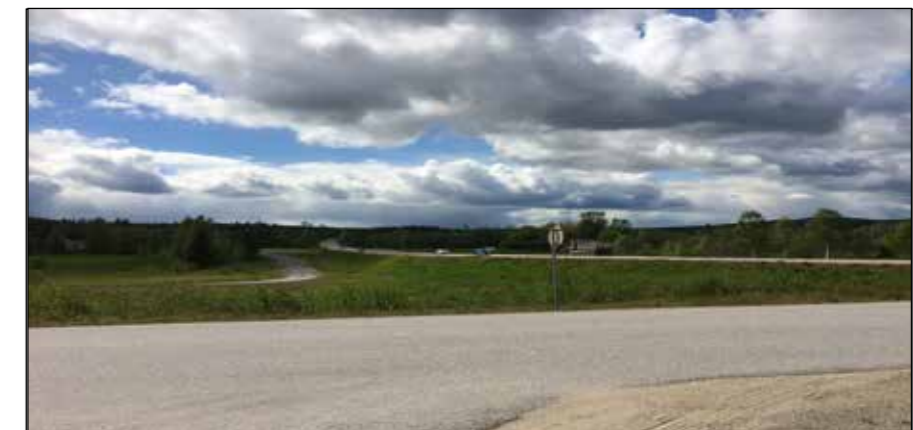
Det parallella vägsystemet består i stor utsträckning av mindre vägar med blandad trafik. Det finns inga separerade gång- och cykelvägar längs med E14.
