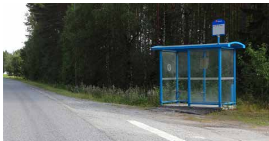
Figur 2.2-6 Exempel på busshållplats vid väg 363.
