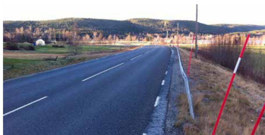
Figur 4.3-10 Väg 363 söder om Taveljö i riktning norrut
