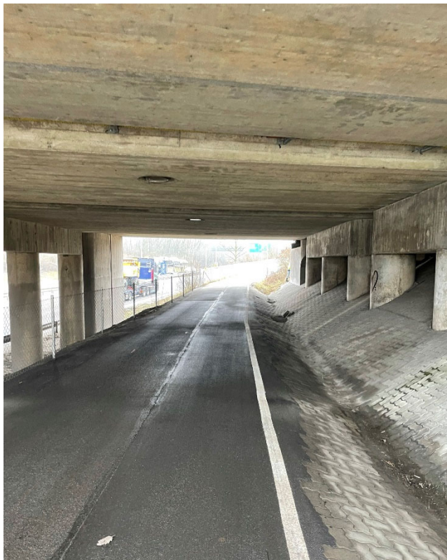
Figur 5.4. Gång- och cykelväg under järnvägen.
