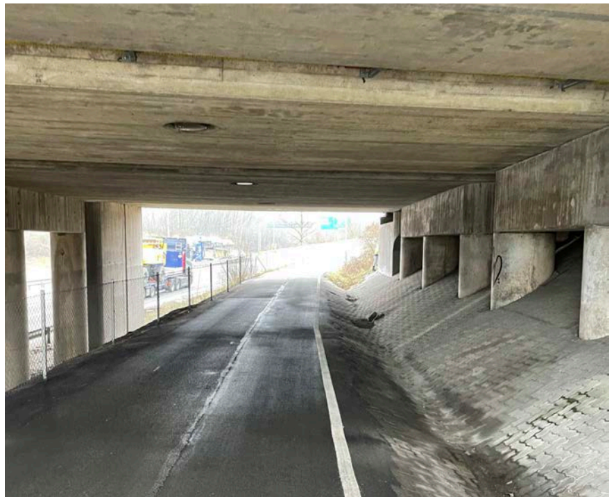
Figur 16- GC-väg under järnvägen
