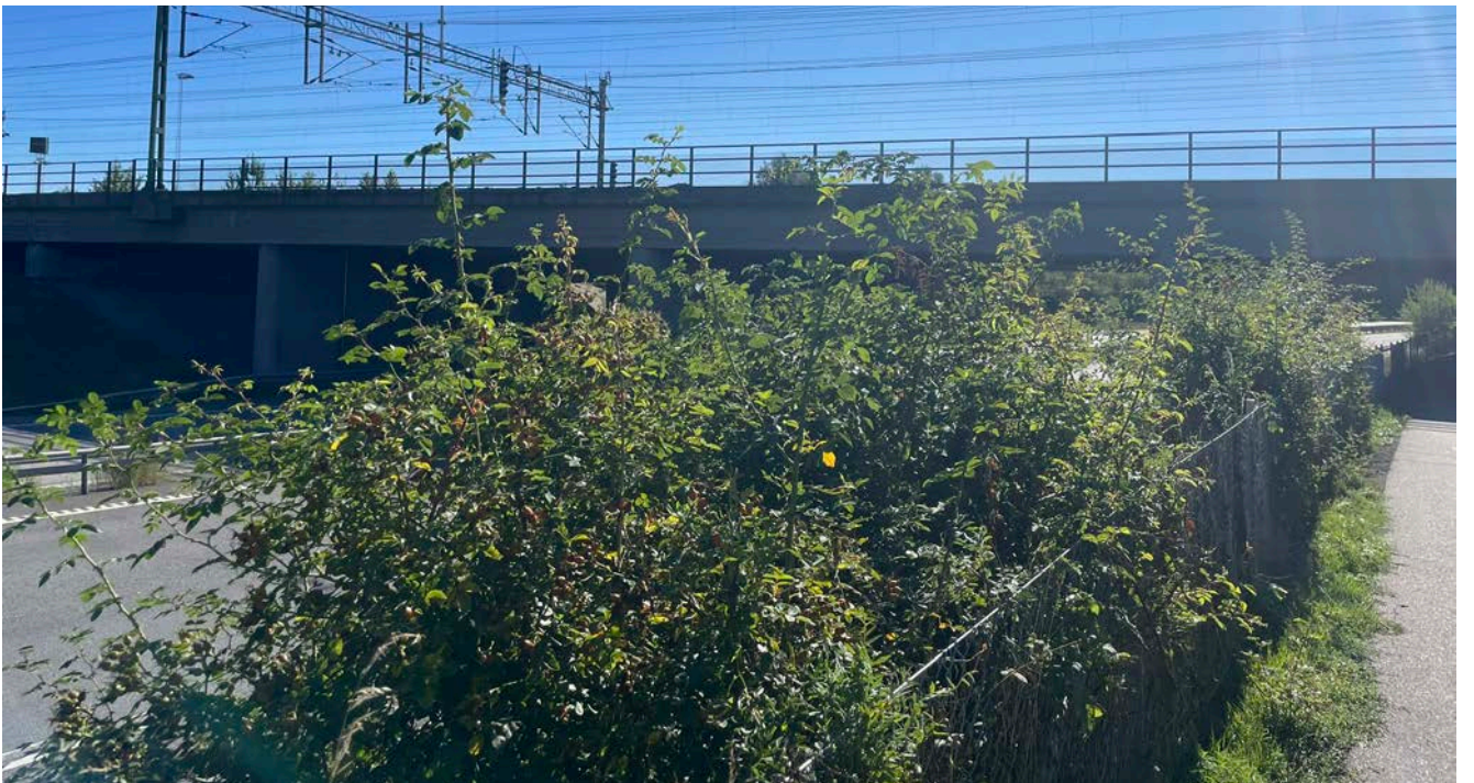
Figur 19-Foton från platsbesök 22-09-01 på passage under bron och omgivande grönska som döljer byggnadsverk samt stora delar av den dominerande infrastrukturen. Grönskan bidrar till en positivare upplevelse av platsen och är därför viktig att återetablera efter anläggning. Bild högst upp till vänster visar cykelväg väster om bron. Bild högst upp till höger visar bron och cykelväg öster om bron. Bild längst ned visar vegetation mellan Inre Ringvägen och cykelväg väster om bron.
