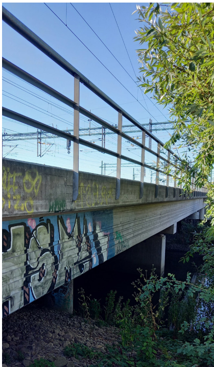
Figur 15-. Befintlig järnvägsbro över Inre ringvägen, sett från nordvästra brofästet.
