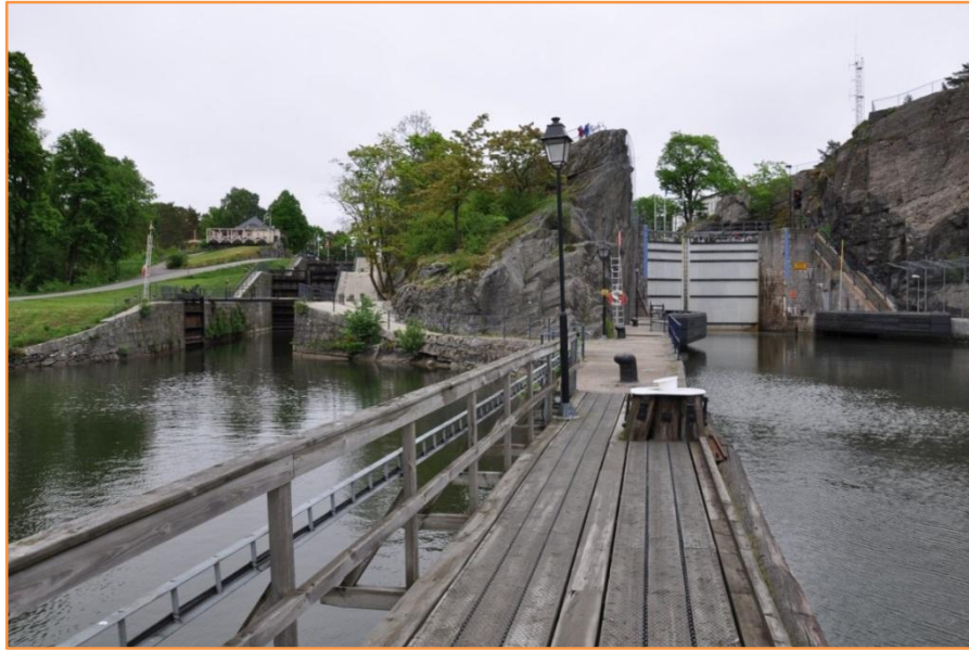
Figur 4 Två generationer av slussar i Trollhättan, t.v. 1844-års slussar och t.h. 1916-års sluss (foto: WSP)
