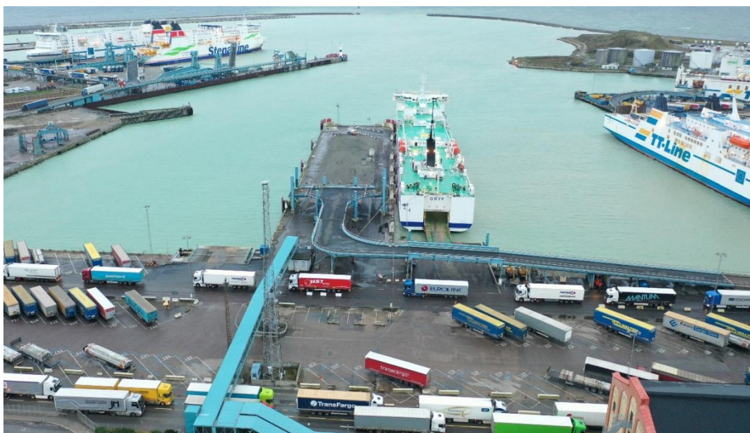
Hamnen sett från passagerarterminalens tak. Foto ©Trelleborgs hamn.
