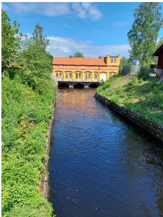
Figur 8. Sundbornsån nedströms kraftverket. Vy mot norr.
