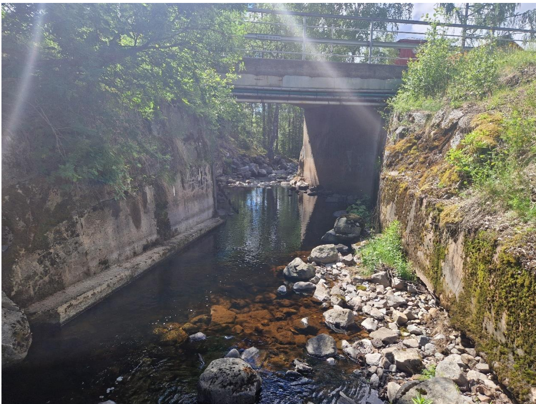
Figur 12. Kallmurar/betongmurar på norra sidan om Lillån. Vy mot söder
