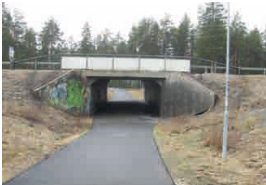
Befintlig gång- och cykelport som utgår när Trafikplats Klockarbäcken byggs.
