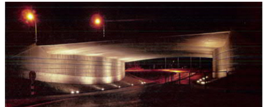
Figur 55. Belysning av gång- och cykelbro under Västra länken.
