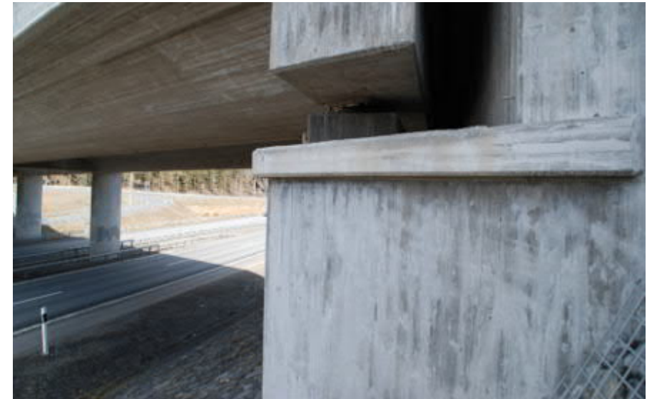
Figur 45. Exempel gjutning i brädform
