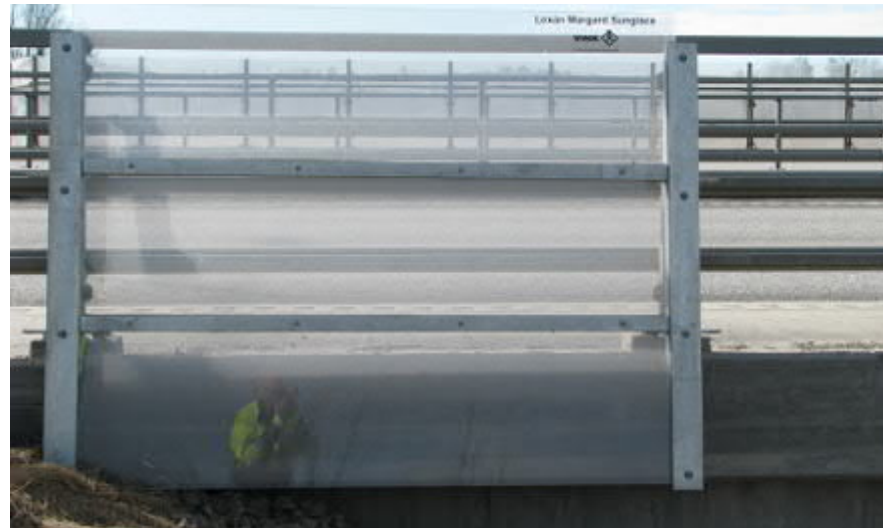
Figur 51. Exempel på genomsiktig bullerskyddsskärm på bro.
