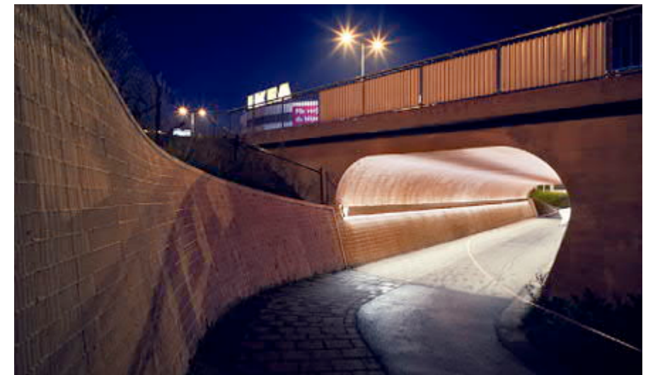
Figur 54. Belysning av gång- och cykelbro under Västra länken.
