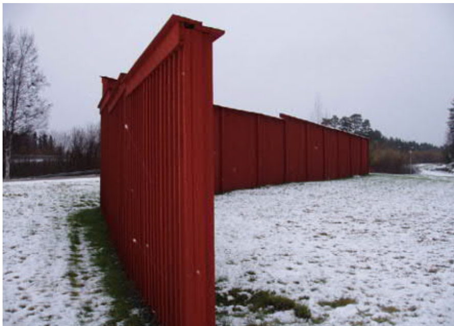
Figur 50. Exempel på traditionellt träplank med lockpanel där höjdskillnad upptragits genom trappning i skärmens överkant.
