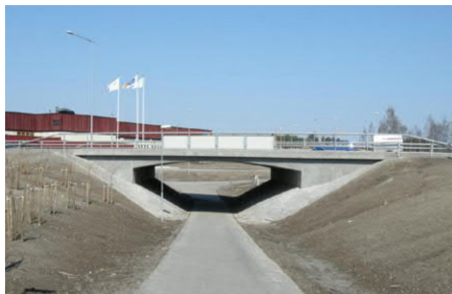
Figur 47. Gång- och cykelbro som är öppen och genomsiktig.
