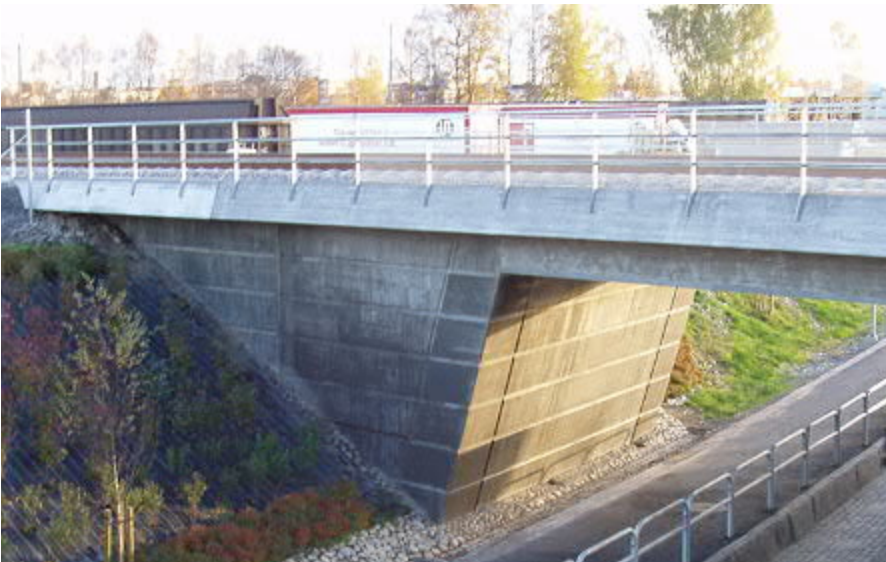
Figur 77. Exempel på horisontell relief i landfästet.
