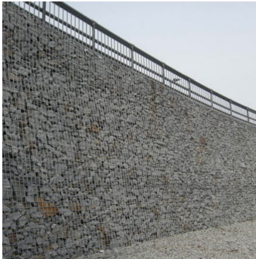
Figur 67. Exempel på gabionvägg
