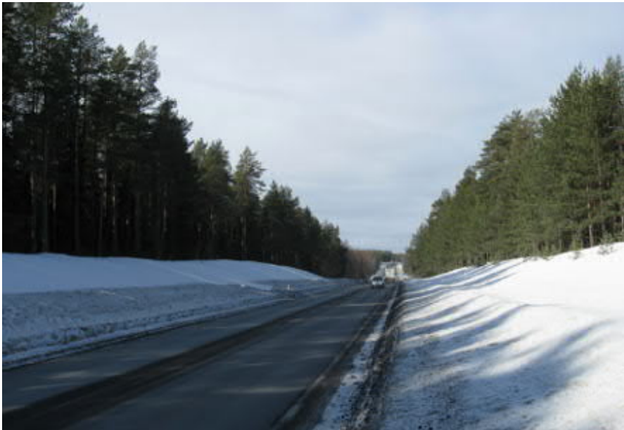
Figur 35. Foto längs med Vännäsvägen där det tydligt avgränsade vägrummet omgivet av tallridåer syns.
