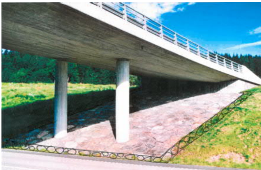
Figur 46. Ordnad stensättning under bro.
