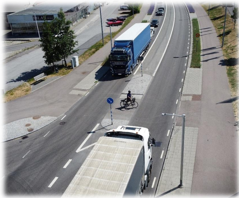
Figur 48: Drönbild över Dragongatan och passage vid Koppargatan i Ystad, Patrick Olsson, Trafikverket
