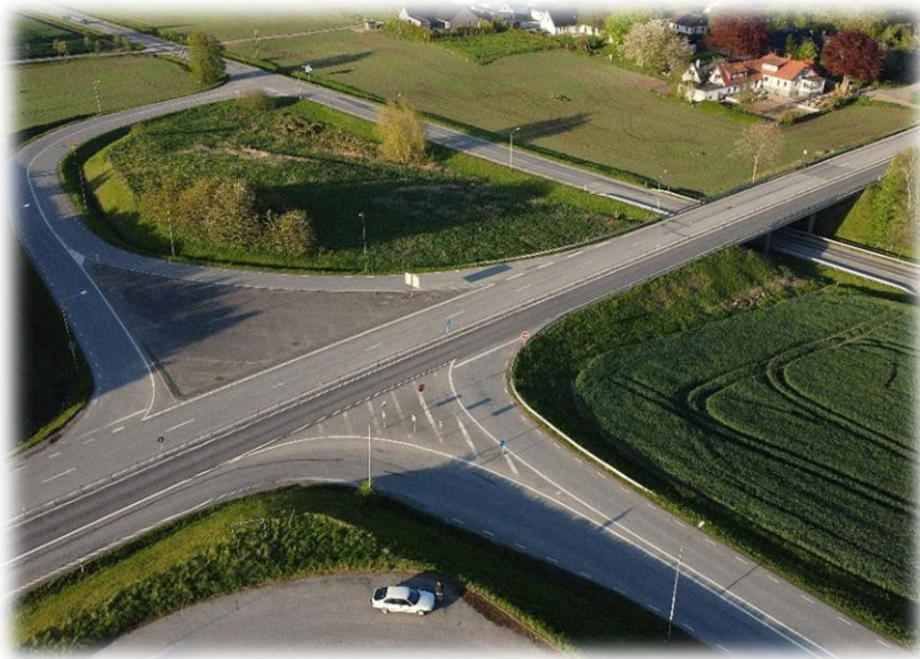
Figur 41: Drönarbild över trafikplats Sandåkra, Patrick Olsson, Trafikverket
