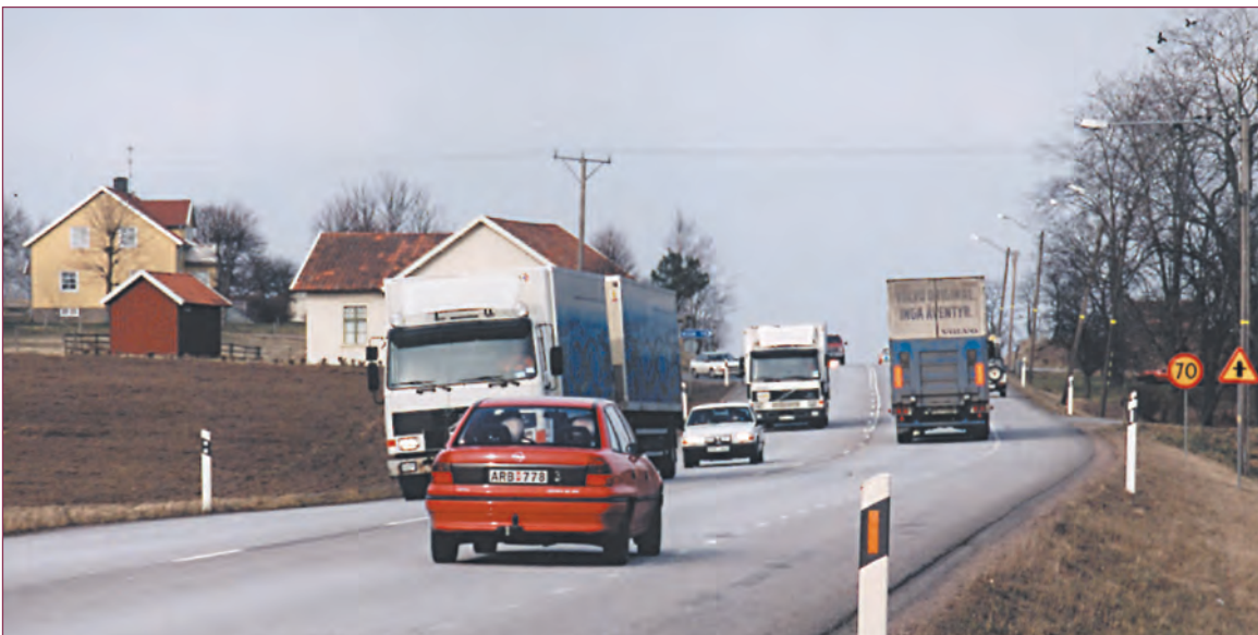
E20 vid Bälinge. Hastigheten är lokalt nedsatt till 70 km/h på grund av farlig vägkorsning nära backkrön.
