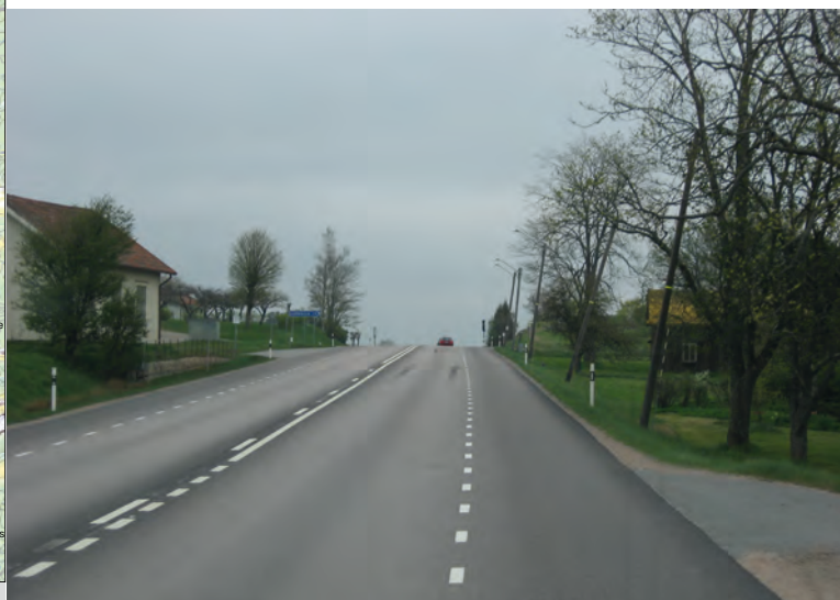
Figur 3.3:1 Befintlig E20 strax söder om korsningen med Kärtaredsvägen.
