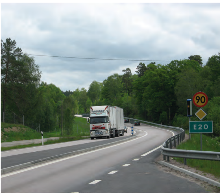
Figur 2.4:1 Befintlig E20 vid Tubbetorp.
