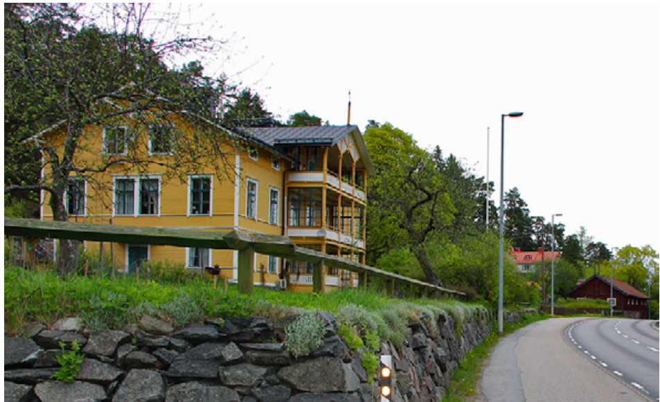
Bild 17. Nacka gårds huvudbyggnad utgör ett landmärke längs sträckan, vy mot norr.
