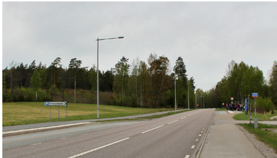
Bild 16. Öppet landskapsrum omslutet av skog vid km 4/200, vy mot norr.
