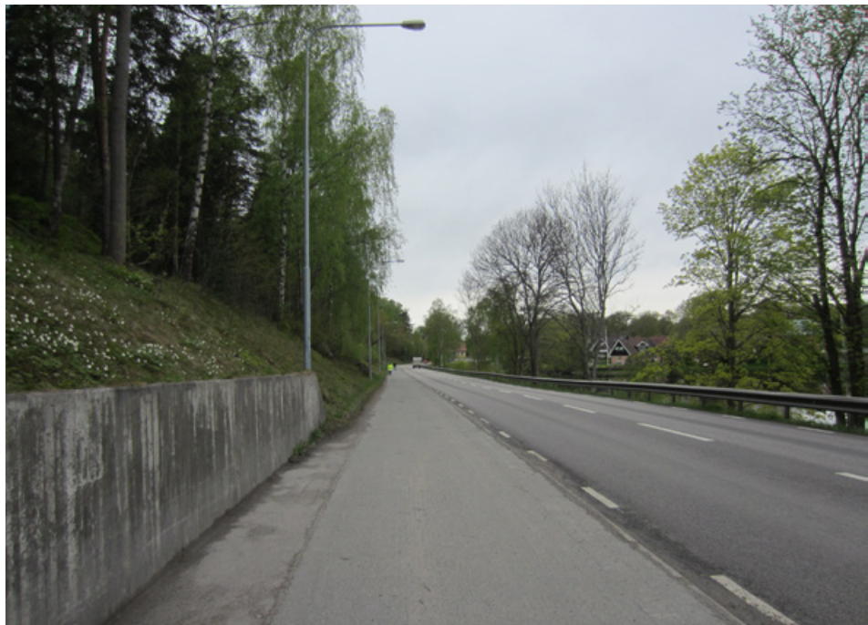
Bild 30. Vegetationsbeklädd slänt och stödmur av betong vid Nackaberget.
