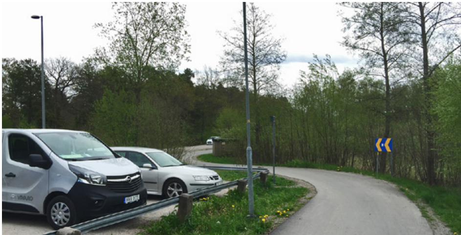
Bild 14. Skarpa kurvor med dålig sikt vid km ca 6/000, vy mot söder.
