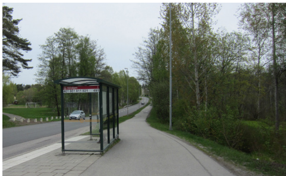
Bild 1. Exempel på hur befintlig gång- och cykelväg ser ut.
