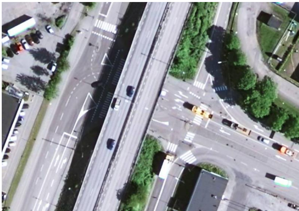
Figur 3. Befintliga broar över Slakthusgatan
