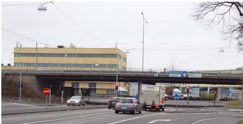
Figur 2. Befintliga broar över Slakthusgatan.
