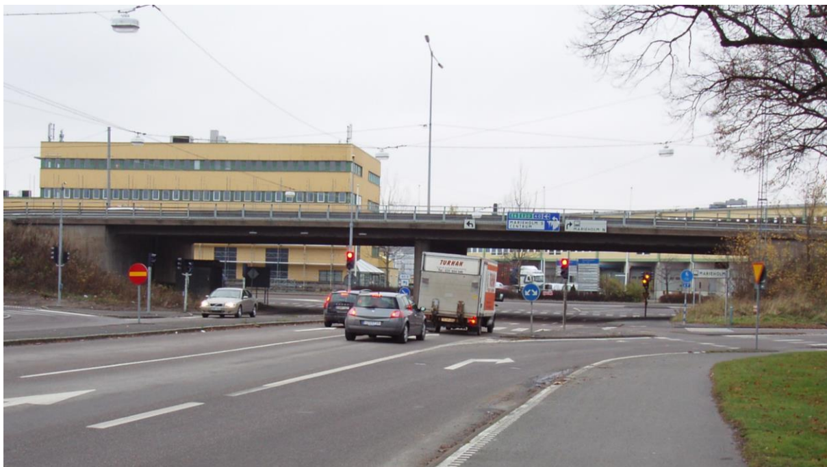
Figur 16. Befintliga broar över Slakthusgatan.
