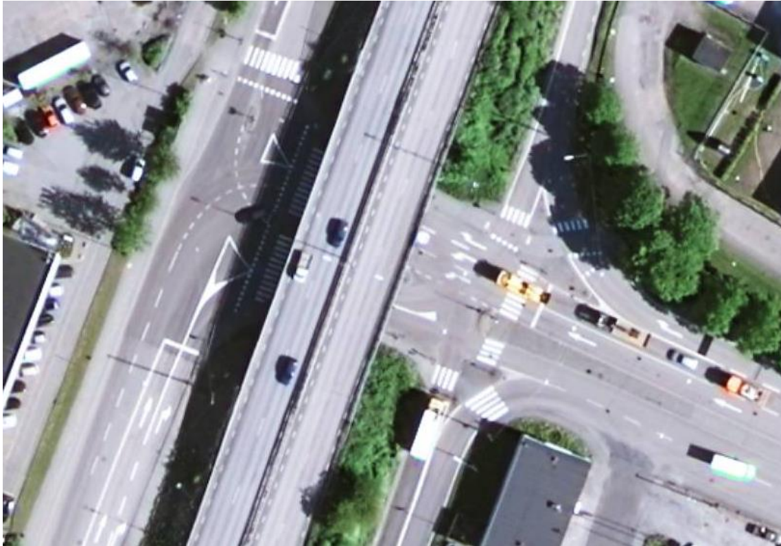
Figur 17. Befintliga broar över Slakthusgatan
