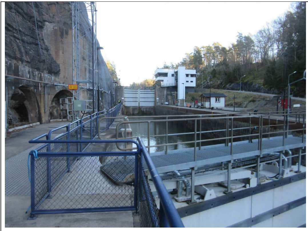
3.2:7 Slusstrappan mellan Höljan och Göta älv breddas mot höger i bild, vilket påverkar flera byggnader och befintlig serviceväg.
