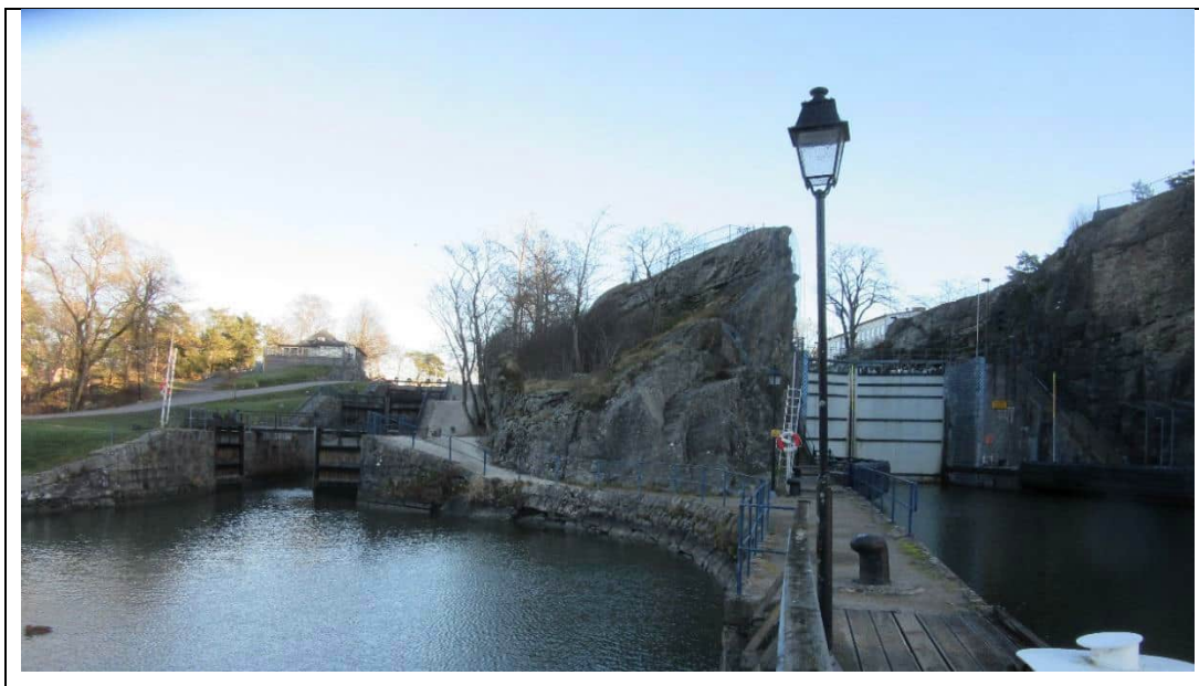
4.4:4 Vy från Höljan mot slusslederna från 1844 och 1916 (nuvarande sluss).
