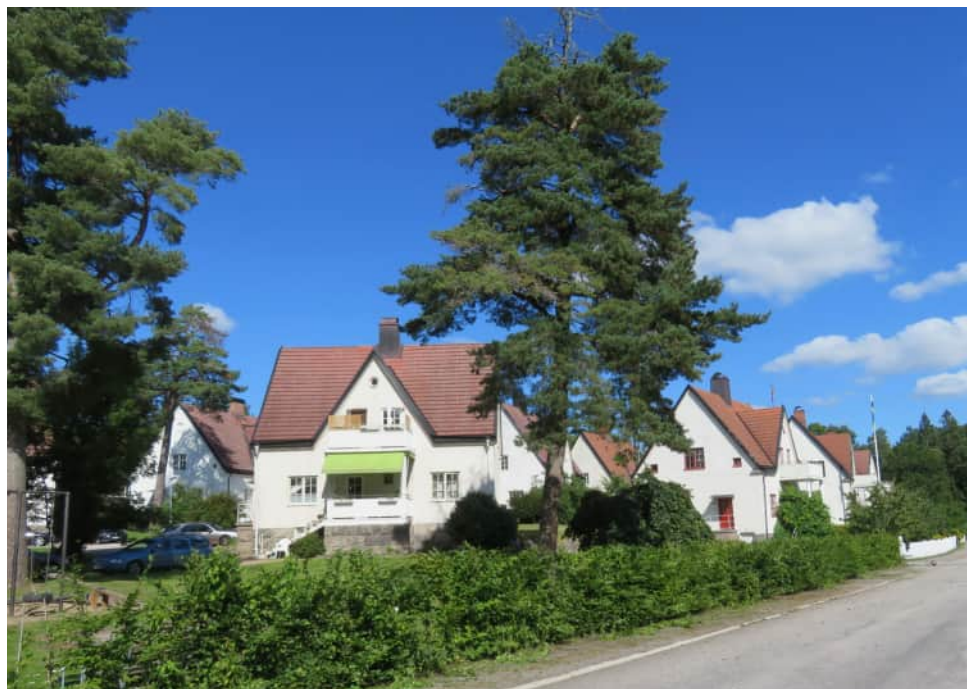
Figur 126. Västergärdet på Olidan. Bebyggelsen har skydd som byggnadsminne.
