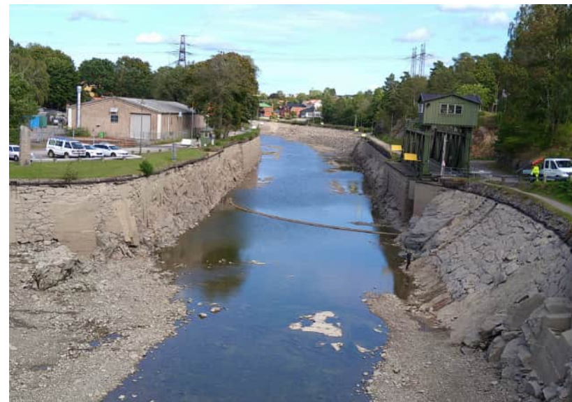
Figur 78. Bergkanalen tillfälligt tömd så att murar och stenskoning syns. T.h. Svängbron från 1915 och i vattnet syns skenan till bron. Över bron kunde tågen nå Nydqvist & Holms verkstäder och Olidans kraftverk.
