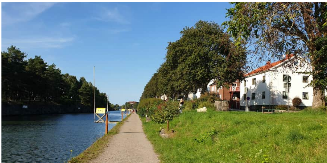
Figur 63. Bergkanalen med dragväg och parkstråk, sett från söder. Söder om rutnätsstadens slutna kvartersstrukturer ligger friliggande hus.
