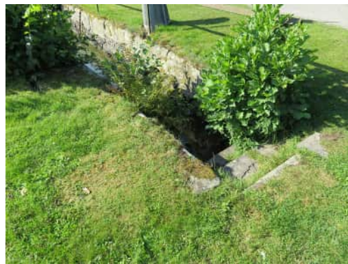
Figur 67. Stenmur och stentrappa på västra sidan av kanalen.
