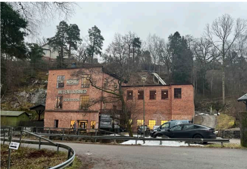
Figur 123. Provstation till kraftverket, tillbyggd i omgångar. Byggnaden är utpekad som kulturhistoriskt värdefulla av Trollhättans stad.
