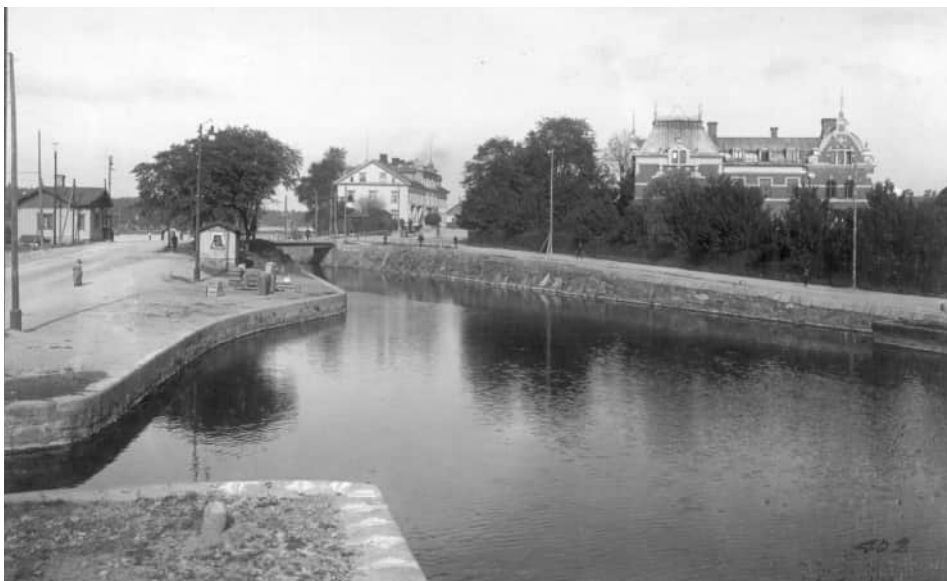
Figur 59. Bergkanalen med vaktbostaden Klaffbron, fotograferade från söder. Okänt år. Sjöfartsverket.
