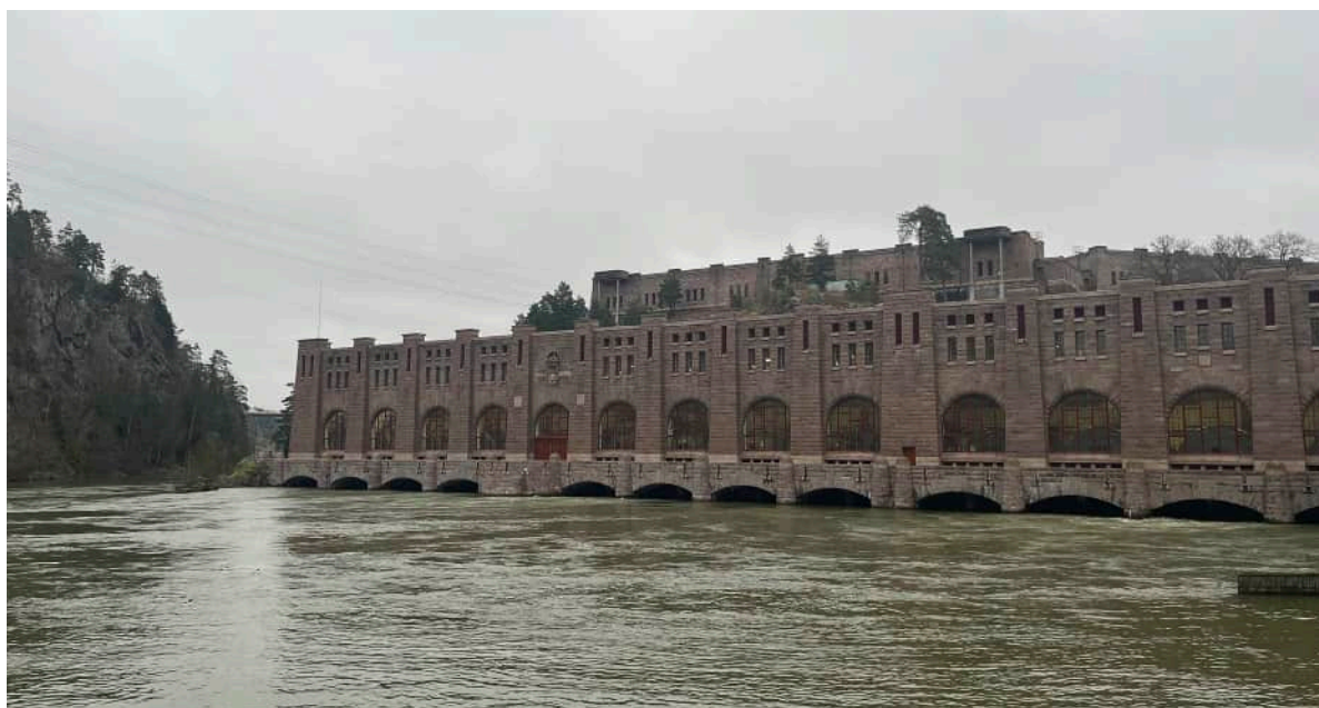
Figur 118. Olidans kraftverk är Sveriges första statliga vattenkraftverk och utgör byggnadsminne sedan 2006.
