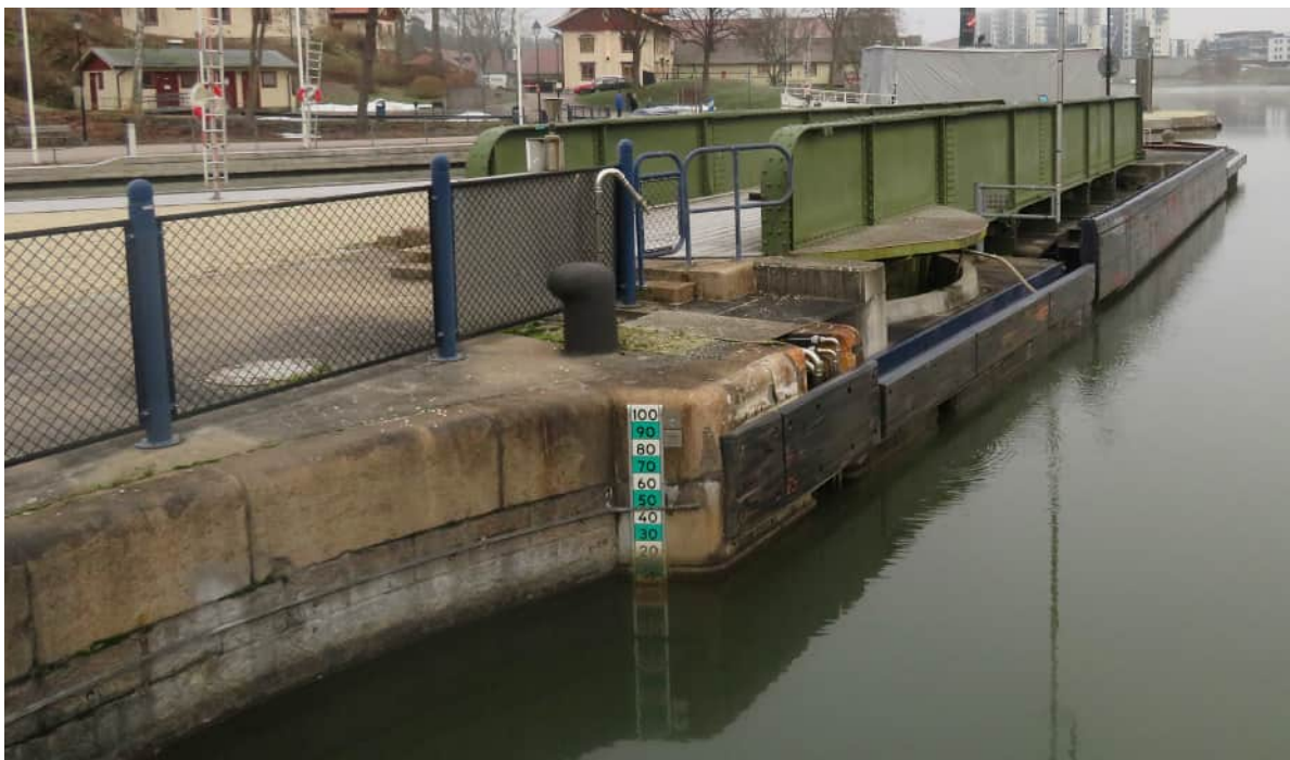
Figur 113. Pir mellan 1844 och 1916 års slussar. Murade kajkanter i sten, pollare i järn samt svängbro.
