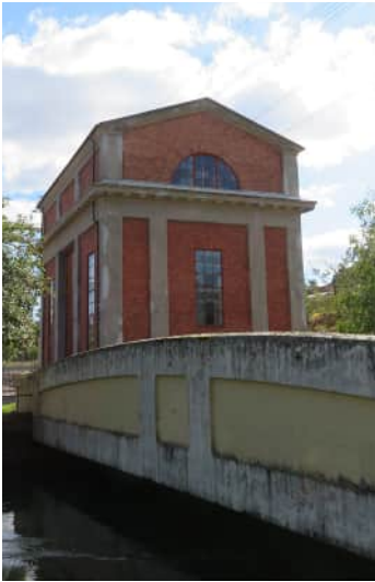
Figur 121. Montagehall från 1921. Byggnaden är utpekad som kulturhistoriskt värdefull av Trollhättans stad.
