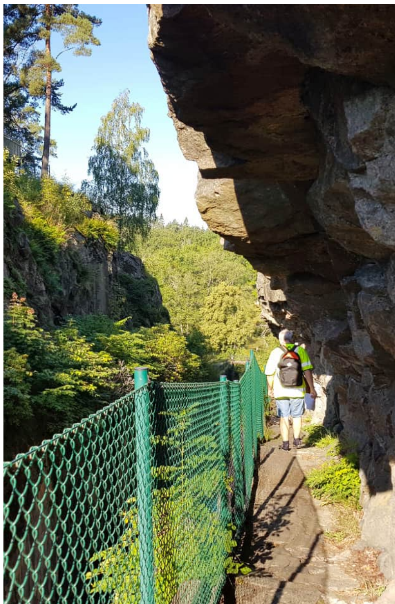
Figur 87. 1800 års övre sluss. De obehandlade bergväggarna där slussen sprängts ut är ett dramatiskt inslag i miljön.
