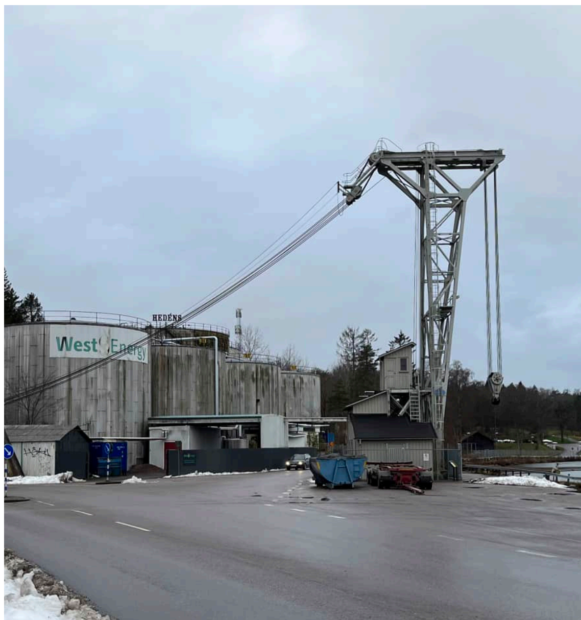
Figur 104. Rysskajen och Rysskranen.
