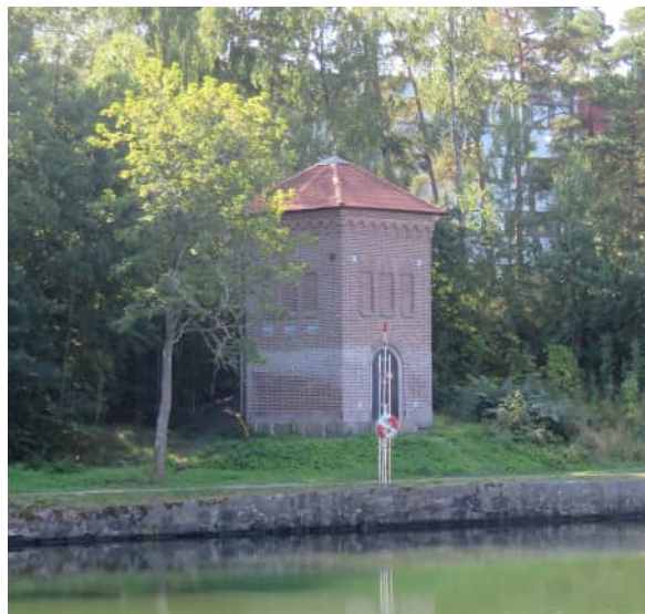
Figur 103. Ställverksbyggnad på östra sidan av kanalen. Byggnaden ligger inom skyddsområdet för det statliga byggnadsminnet, men är inte förtecknad i beslutet.
