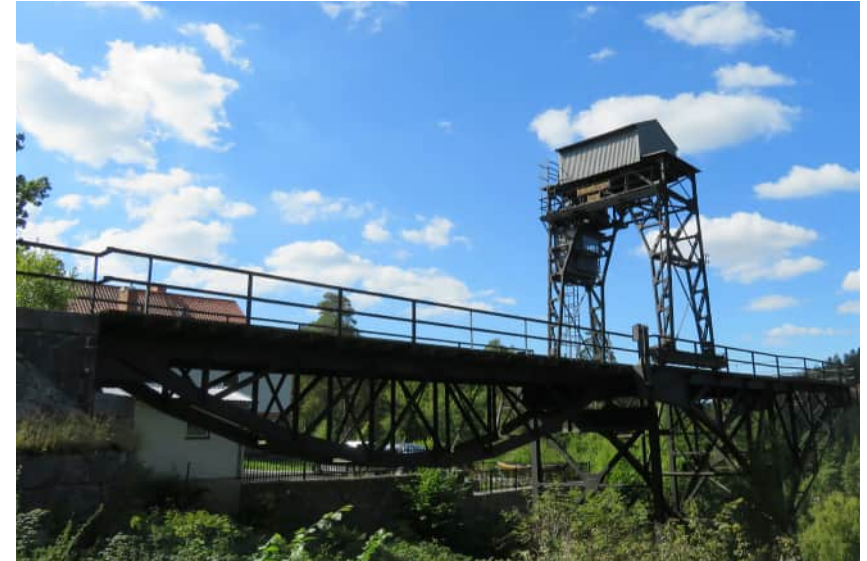
Figur 124. Bockkranen. Genom en järnväg som gick från svängbrom vid Bergkanalen kunde tågen köra ut på kranen. Bockkranen ingår i byggnadsminnet.
