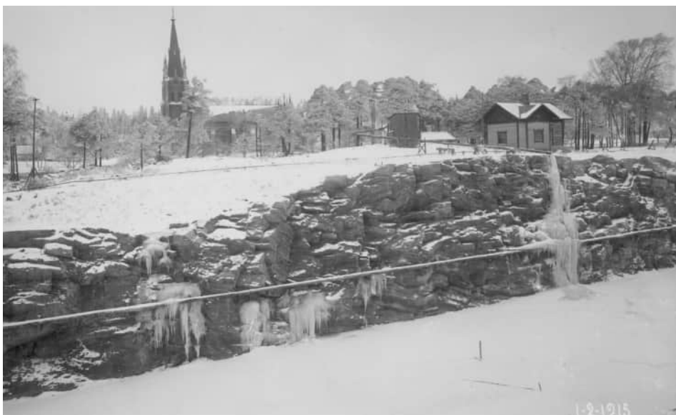
Figur 61. Sprängd del av Bergkanalen och vaktbostaden Kanalön sedda från öst 1915. Trollhättans kyrka syns i bakgrunden. Sjöfartsverket.
