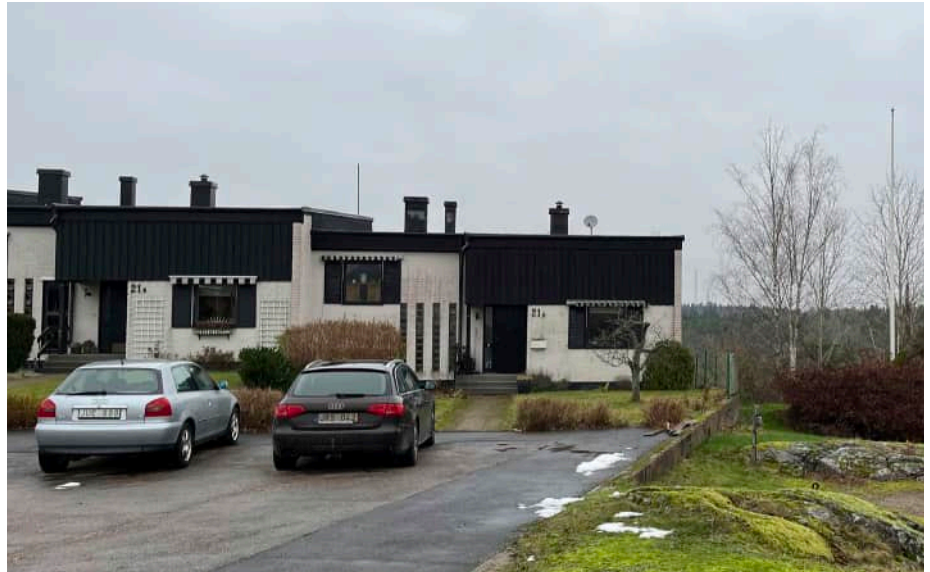
Figur 134. Dalahöjd 3, 4 och 5 - radhus från 1975 har en väl genomarbetad arkitektur från tiden. Byggnaden är utpekad som kulturhistoriskt värdefull av kommunen.
