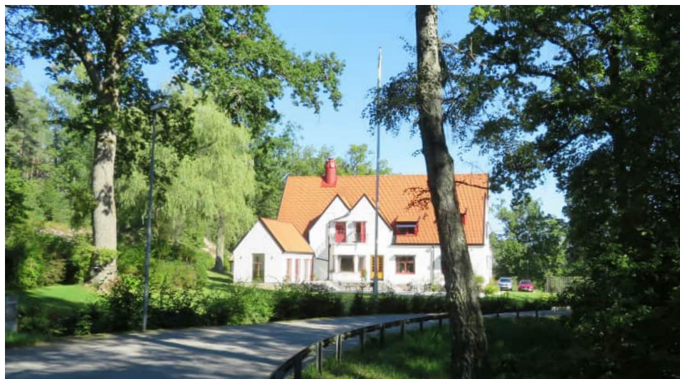
Figur 127. Villa Skogsvreten. Byggnaden är utpekad som kulturhistoriskt värdefull av Trollhättans stad. Den har samma uttryck som Västergärdets villor.
