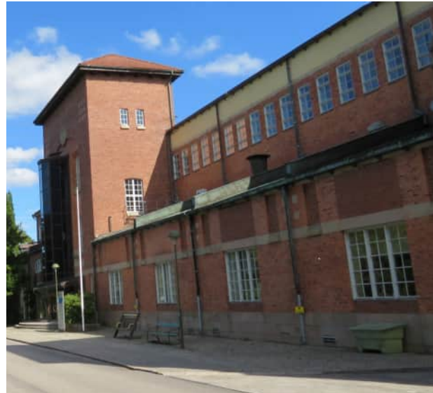
Figur 122. Ställverksbyggnad i anslutning till kraftverket, uppförd 1908 och senare tillbyggd. Byggnaden är utpekad som värdefull av Trollhättans stad.
