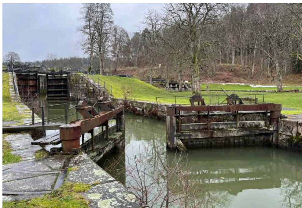
Figur 90. 1844 års slussar med slussportar och tekniska installationer, nedersta etappen.
