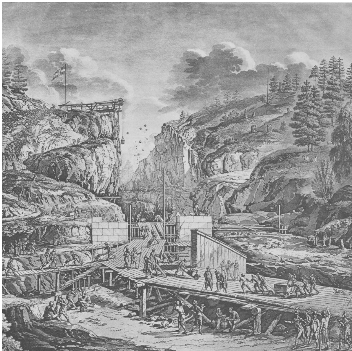
Figur 32. 1800 års slussled under byggnad år 1798. Platsen på bilden är sluss 4-8 i Höga Berget, norra delen av 1800 års slussled. Etsning/gravyr av Louis Belanger. Sjöfartsverket.
