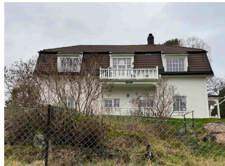
Figur 101. Inom området finns byggnader som inte omfattas av det staliga byggnadsmiljöet men som pekats ut som kulturhistoriskt värdefulla av kommunen. Det gäller bland annat Åker 10:3 på fotot.
