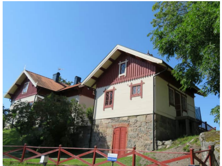
Figur 97. Bokhållarbostaden med källarbod är exempel på byggnader med särskilt välbevarad karaktär.
