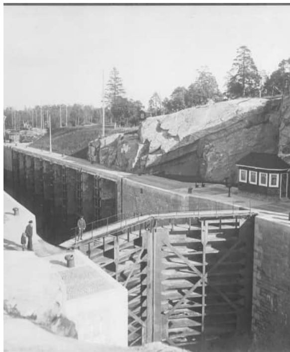
Figur 45. Del av 1916 års slussanläggning. Vid varje port står en manöverhytt. Foto 1916, Sjöfartsverket.
