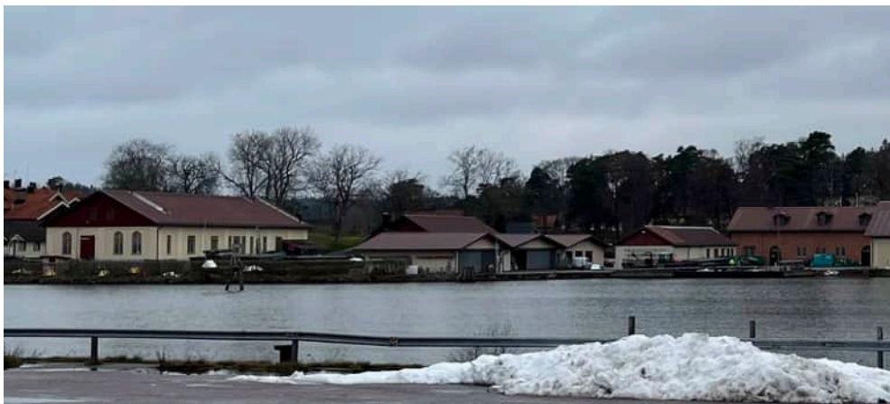
Figur 96. Välbevarad, karaktärsskapande verksamhetsbebyggelse på förrådsgården.
