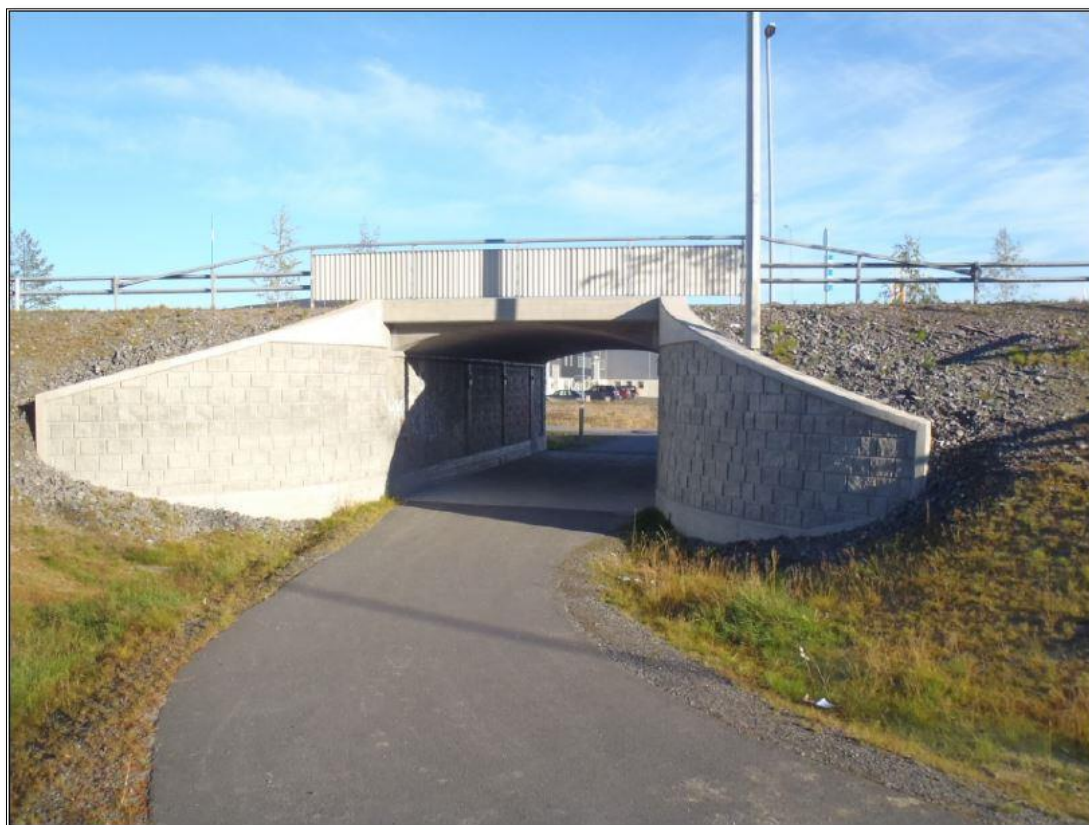
Figur 2. Exempel på gång- och cykelpassage av betong.
