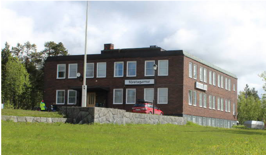
Figur 4-2. Företagshotellet, finns på fastigheten Snorre 1 och är en byggnad som kan ha kulturhistoriskt och arkitektoniskt värde från samma tid som stadshuset.
